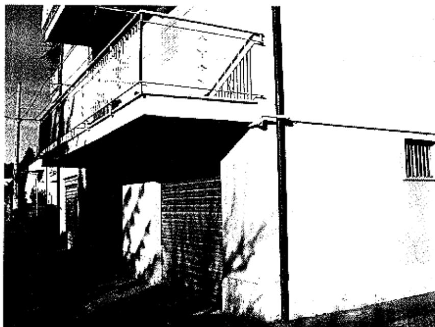
FOTO n.3 Vista edificio corte comune - Lato sud
