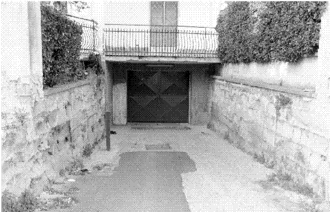
Fotografia 34 – L'accesso carrabile al locale garage del fabbricato dalla strada è dotato di cancello scorrevole in ferro automatizzato.
