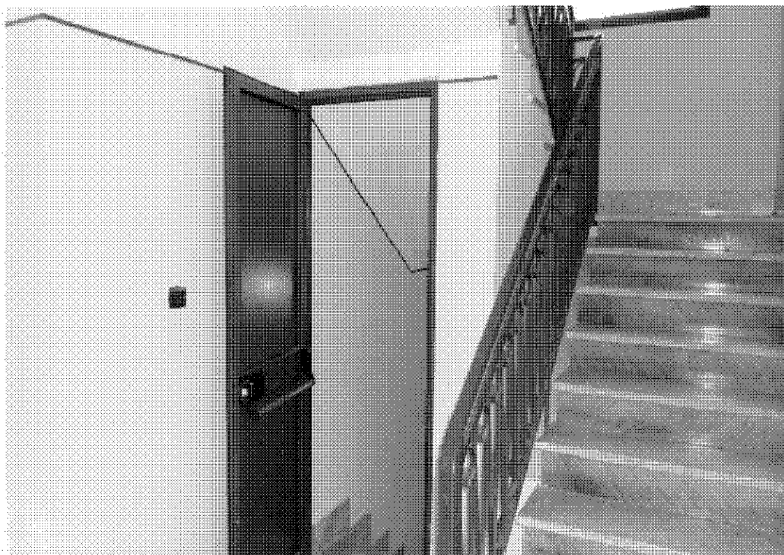
Fotografia 35 – Al locale garage vi si accede anche direttamente da un accesso pedonale attraverso la scala condominiale del fabbricato.
