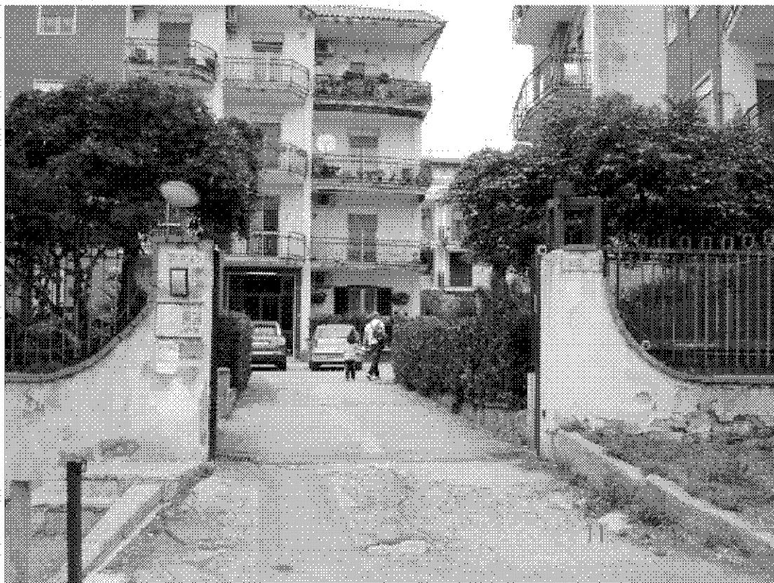
Fotografia 8 – L'accesso carrabile, è protetto da cancello in ferro automatizzato ed è dotato di citofono esterno.
