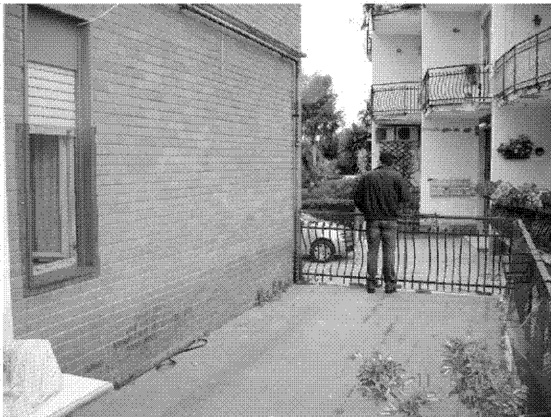
Fotografia 32 – Altra vista Balconata 1.
