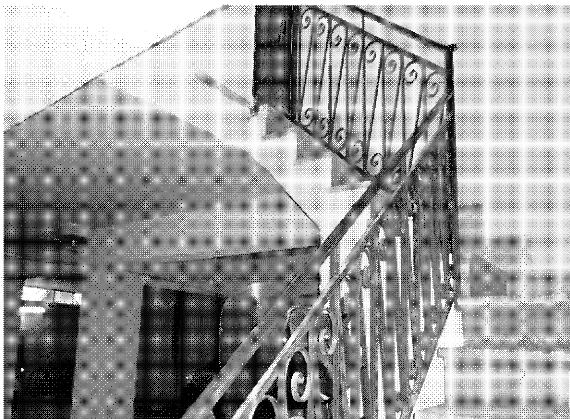
Fotografia 36 – Altra vista accesso pedonale al garage.
