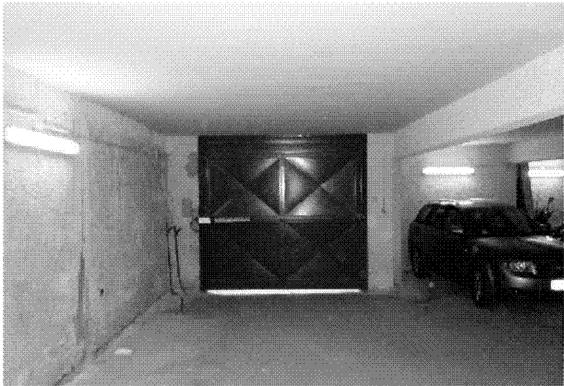
Fotografia 40 – Altra vista accesso pedonale al garage.
