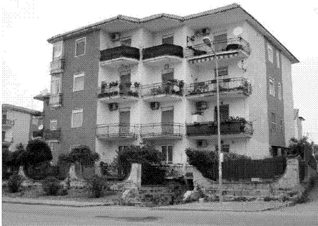
Fotografia 13 – Particolare facciate laterale e posteriore prospiciente la via Staffetta e traversa Staffetta.
