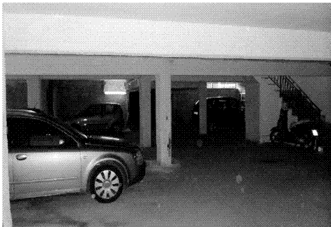
Fotografia 38 – Altra vista accesso pedonale al garage.
