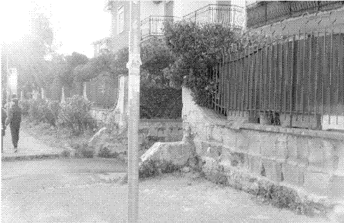
Fotografia 33 – Ingresso al piano interrato del fabbricato destinato a garage dalla Via Staffetta.
