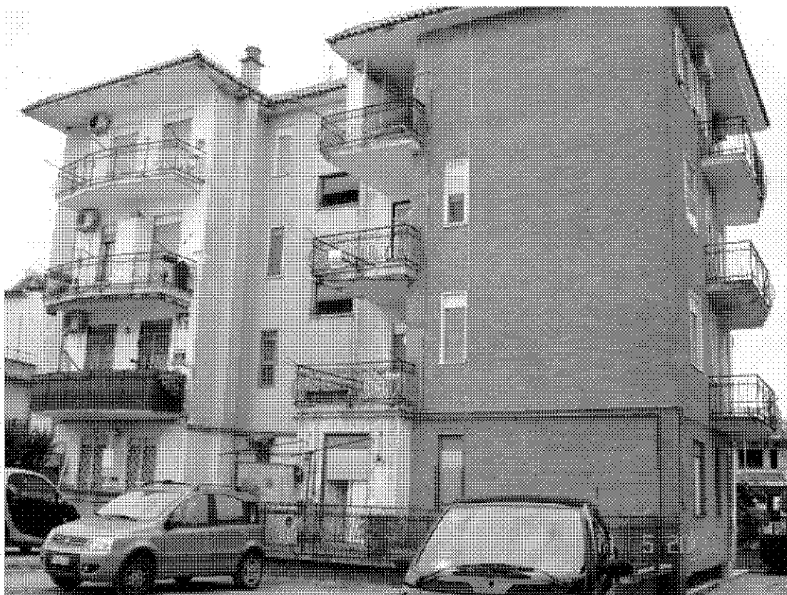
Fotografia 14 – Particolare facciata laterale prospiciente l'area interna del parco.
