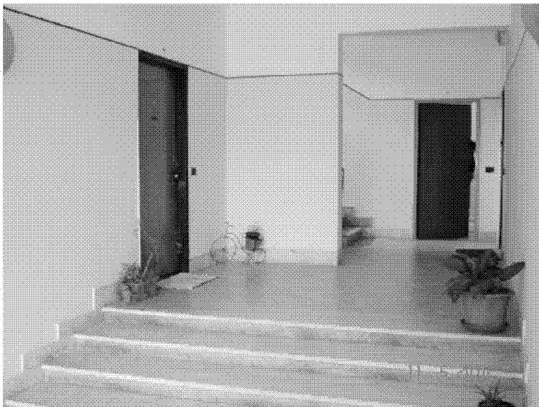
Fotografia 16 – Vista dell'androne fabbricato; lo stesso è pavimentato con piastrelle di gres, il tutto in buono stato di conservazione e manutenzione.
