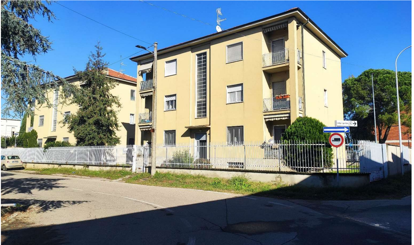
Foto n. 1 – Prospetto del fabbricato
