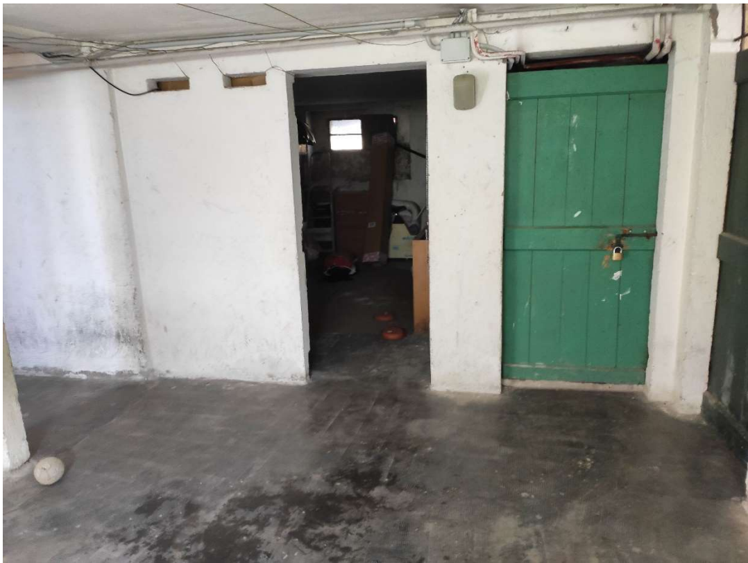
Foto n. 14 – Accesso alla Cantina
