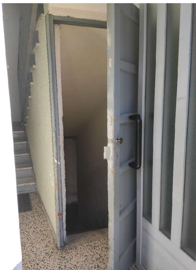
Foto n. 13 – Accesso alle cantine
