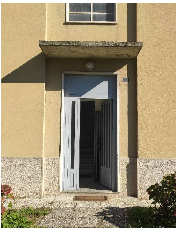
Foto n. 3 – Ingresso al fabbricato
