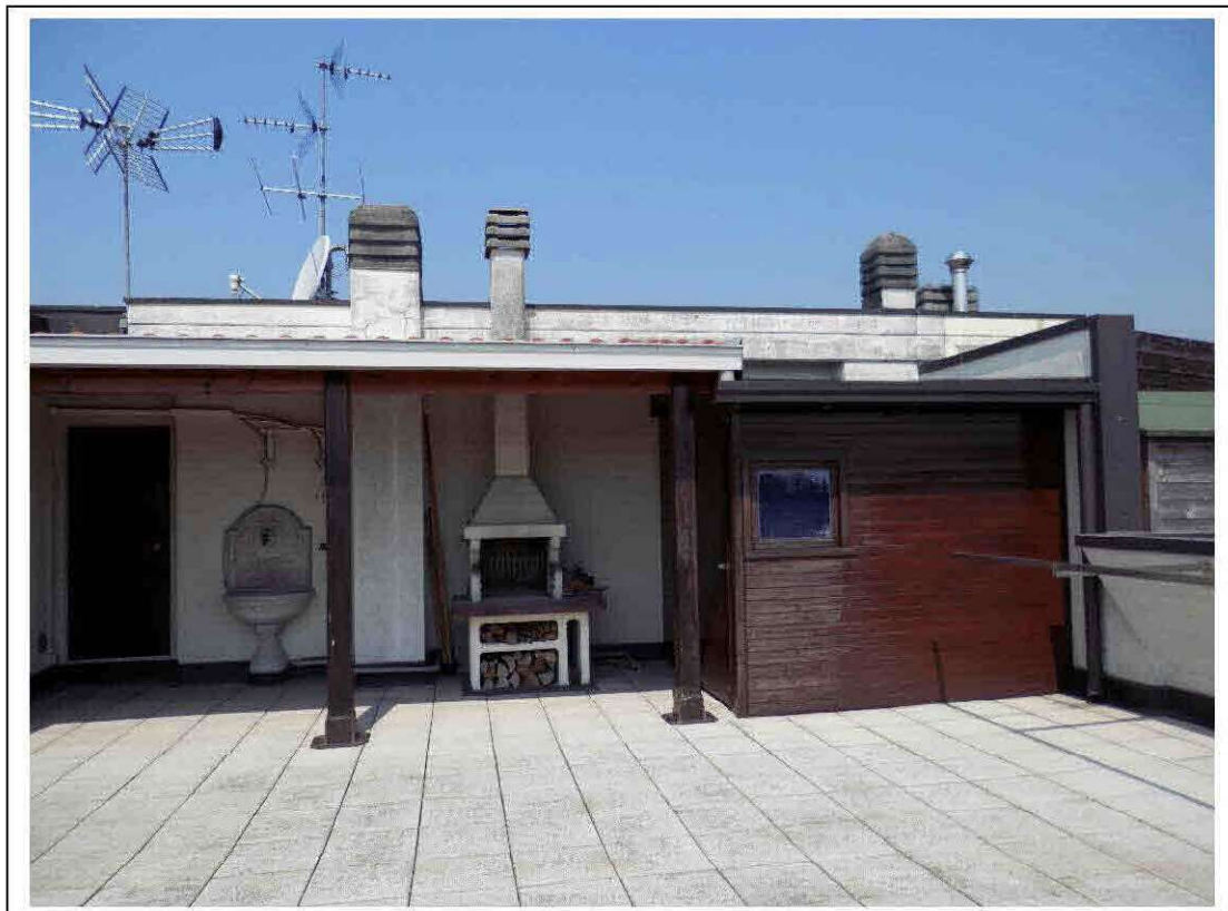
Fotografia n°22 – Vista della terrazza al piano settimo e del vano ripostiglio in legno.
