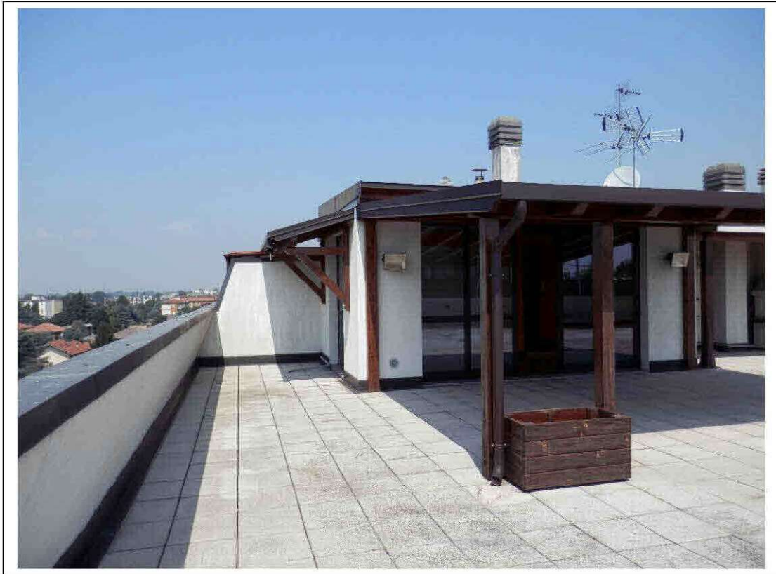
Fotografia n°21 – Vista della veranda dal terrazzo del settimo piano.
