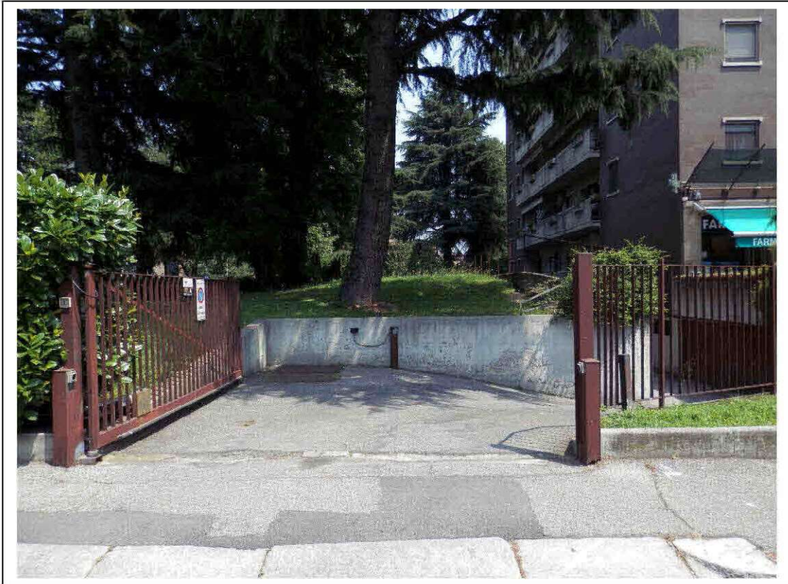
Fotografia n°3 – Vista dell'accesso carraio al fabbricato.
