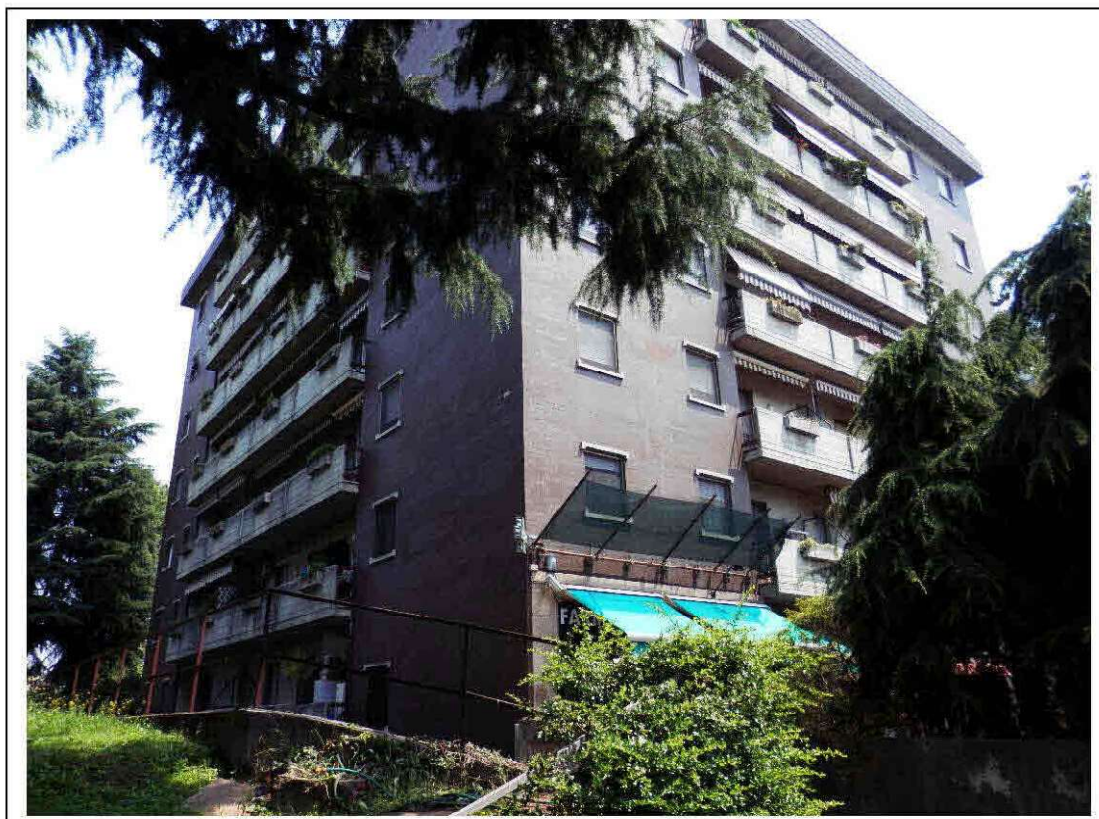
Fotografia n°2 – Vista della facciata del fabbricato da Via Oreglio.
