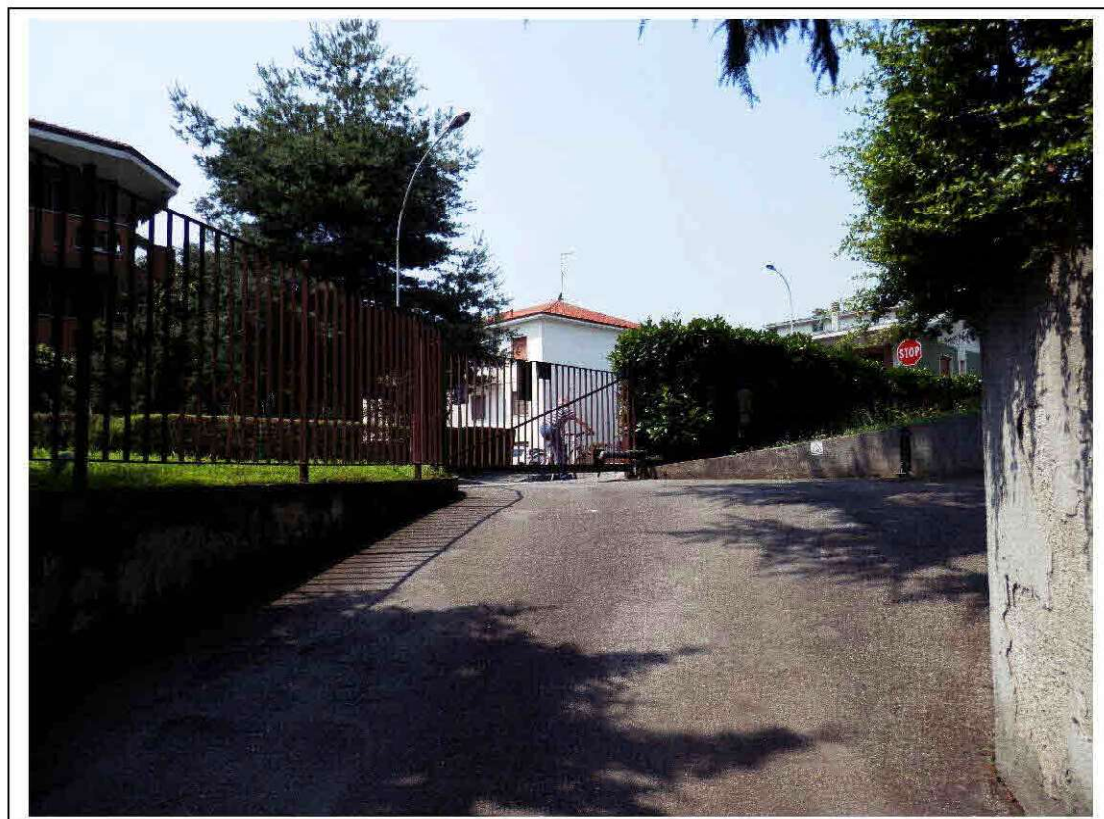
Fotografia n°4 – Vista della rampa d'accesso al piano seminterrato destinato a boxes auto.
