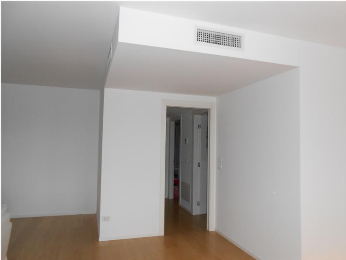
47) Veduta disimpegno zona notte
