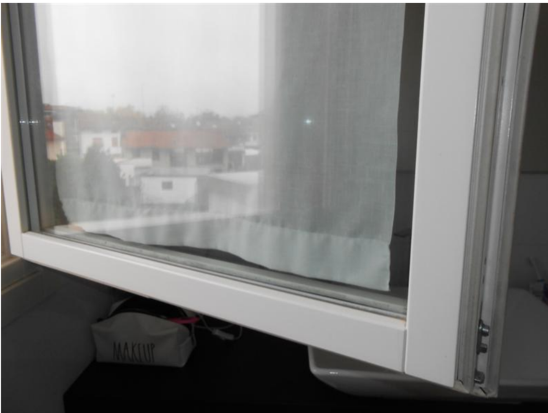
72) Particolare finestra bagno 1
