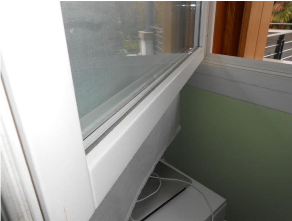
112) Particolare finestra camera 3
