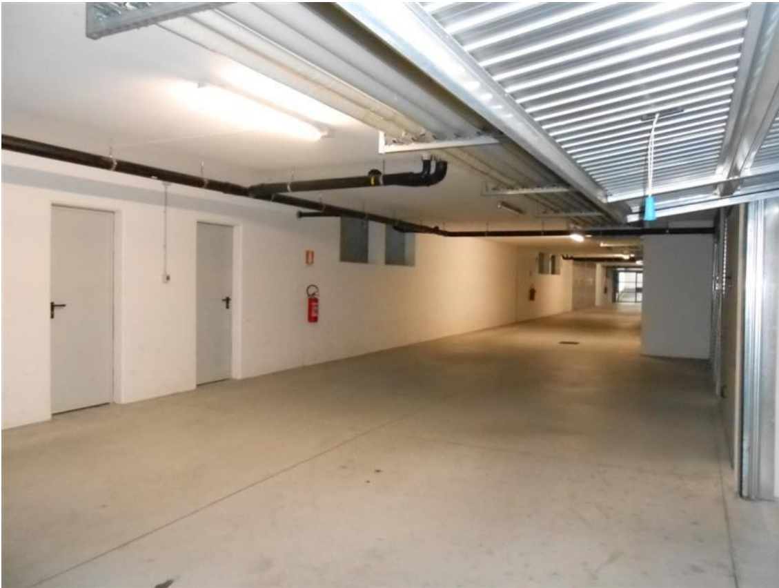
19) Veduta dell'area di manovra antistante il garage
