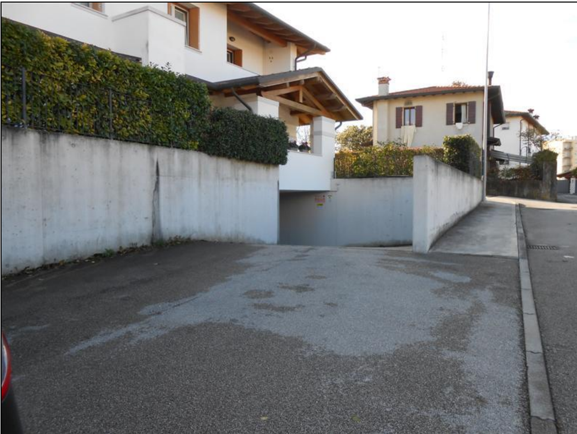
2) Particolare della rampa
