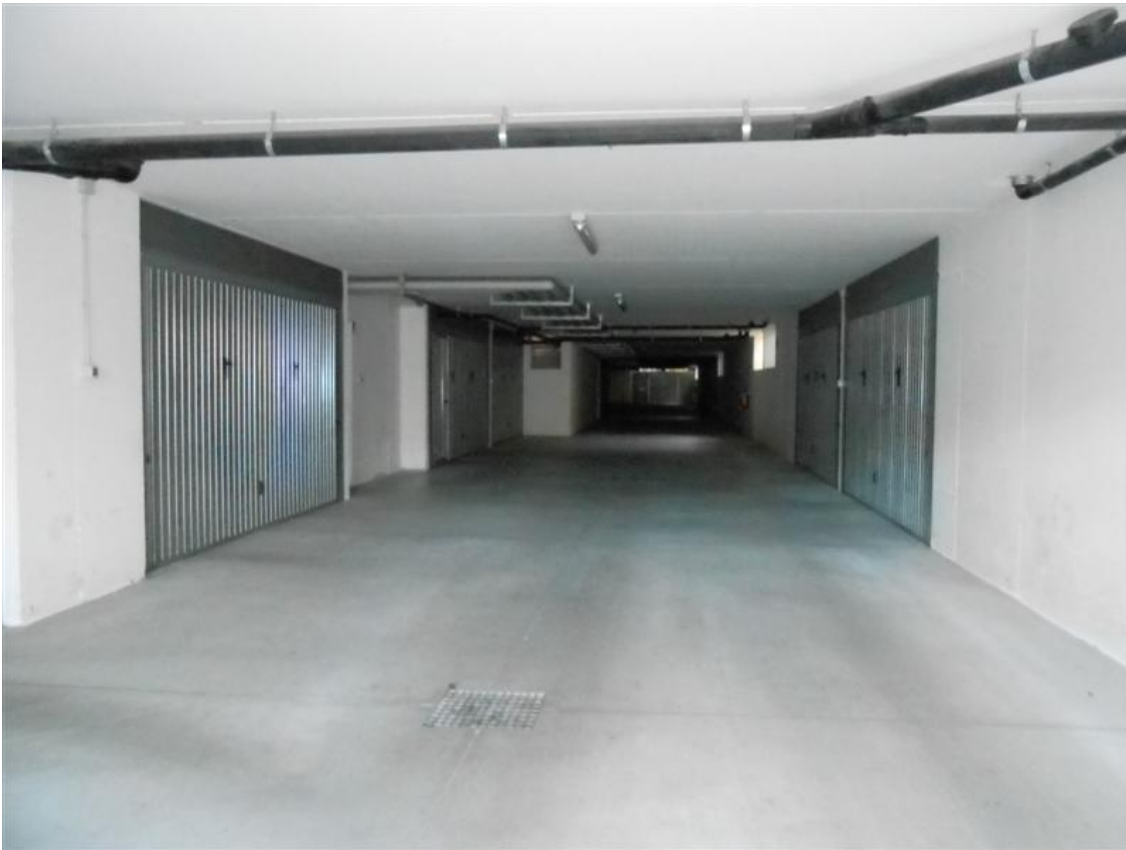
7) Vedute d'insieme del piano interrato
