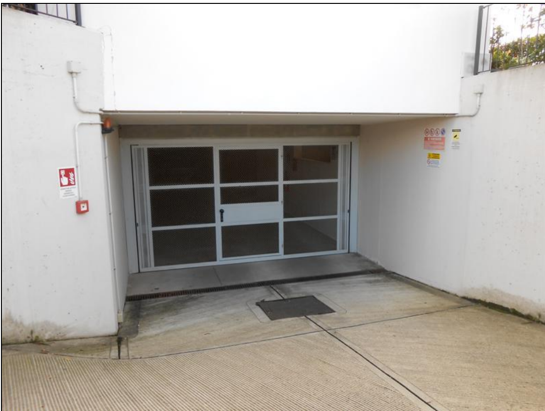
4) Ingresso dalla rampa
