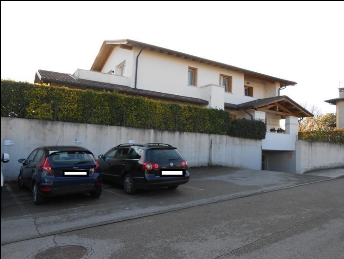
1) Rampa carrabile di accesso al garage
