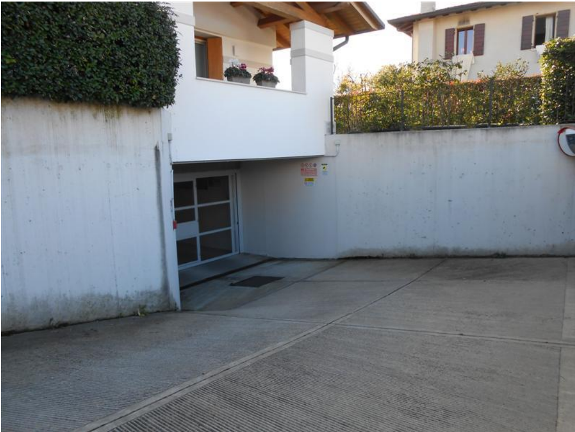
3) Portone di ingresso al piano interrato dalla rampa
