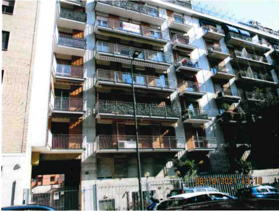
Accessi carraio e pedonale Via Negroli 12
