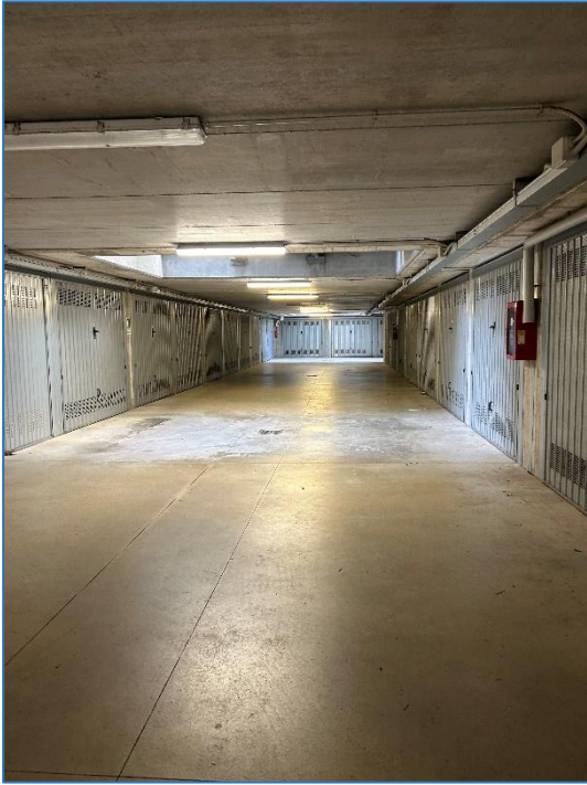
Foto 13 - spazi di manovra comune
