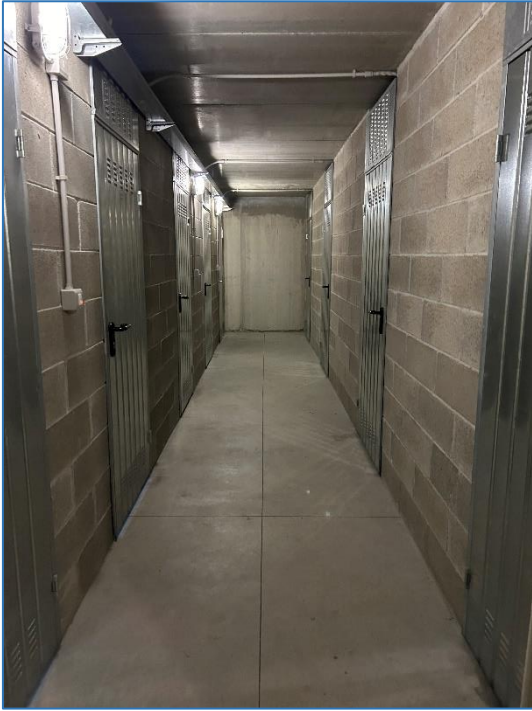
Foto 9 - corridoio comune piano cantine
