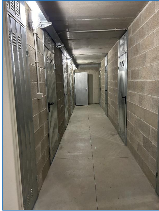
Foto 10 - corridoio comune piano cantine
