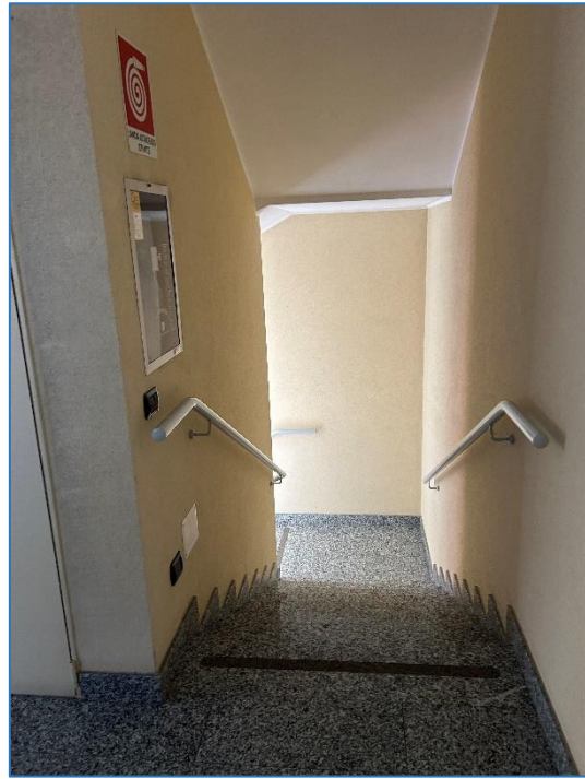
Foto 6 - vano scala comune
