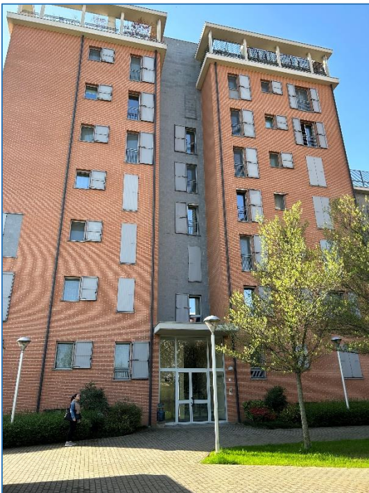
Foto 3 - fabbricato via Oberdan n. 1
