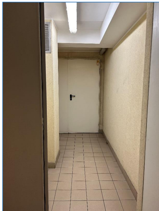
Foto 8 - corridoio comune piano cantine
