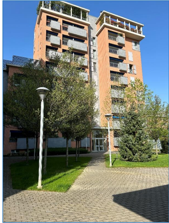
Foto 2 - fabbricato via Oberdan n. 1
