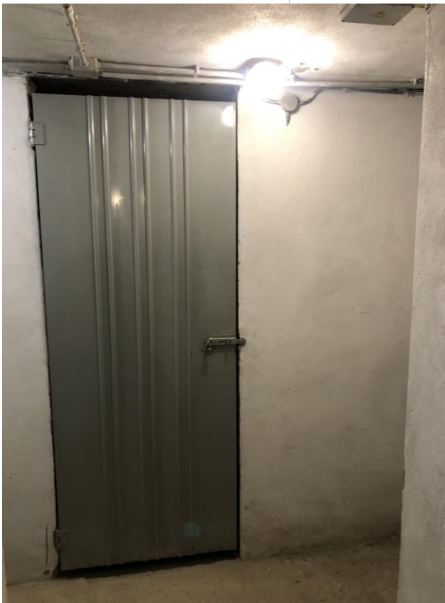
VISTA PORTA CANTINA DI PERTINENZA
