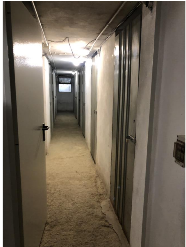
VISTA LOCALI CANTINE
