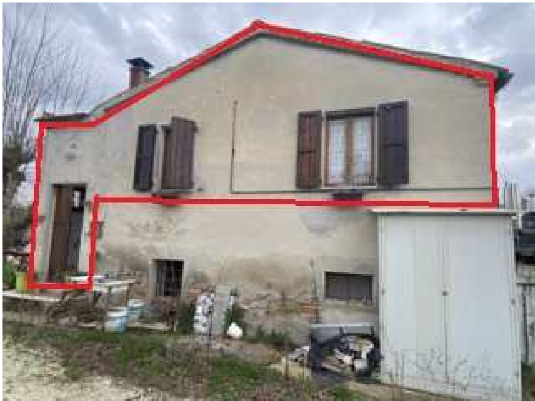
foto 11 - veduta esterna dell'azienda sul lato Est (in primo piano la porzione a capanna in calcestruzzo già condonata)
