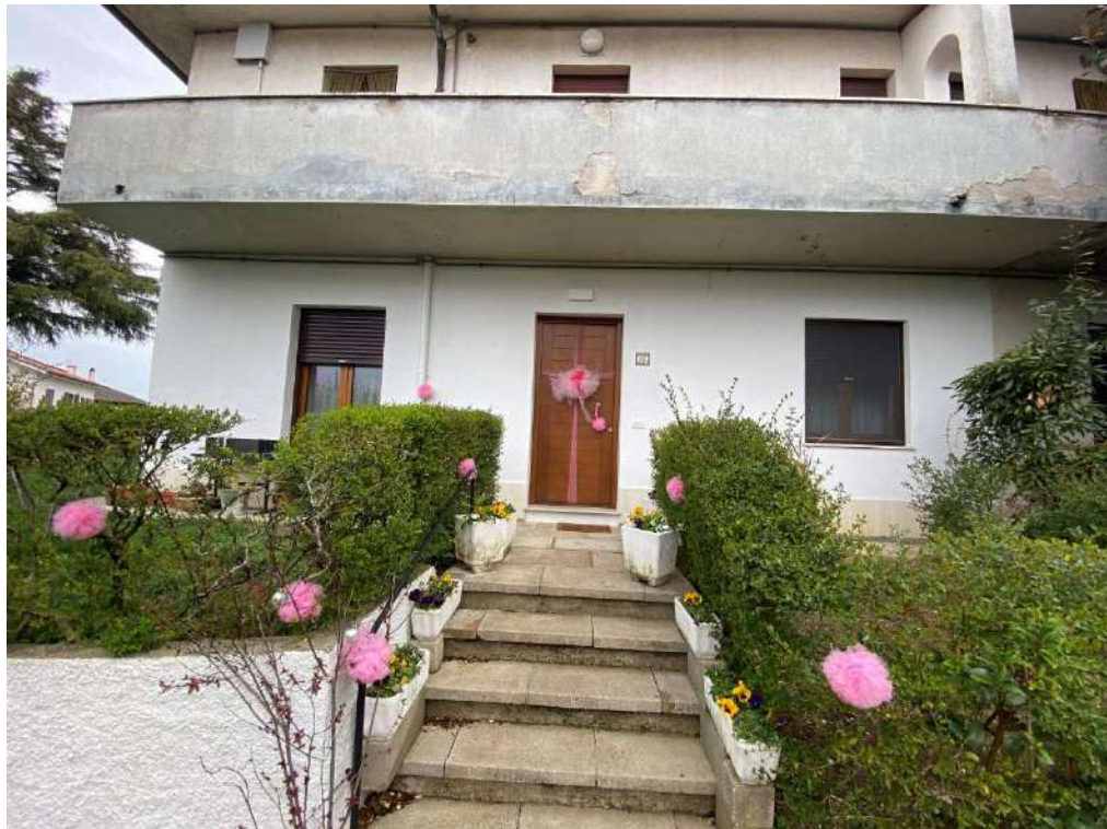
foto 16 - veduta esterna dell'ingresso all'u.i. PT dal vialetto comune (vedi foto 18 sotto riportata)
