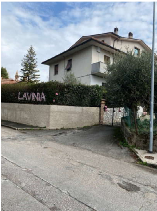
foto 17 - veduta esterna del fabbricato da via Palmiro Togliatti 25
