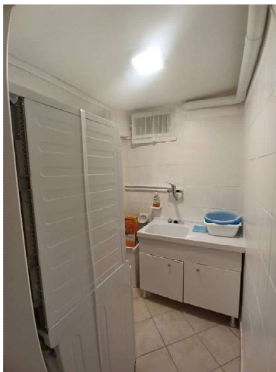
foto 24 - veduta della cantina al PS1
