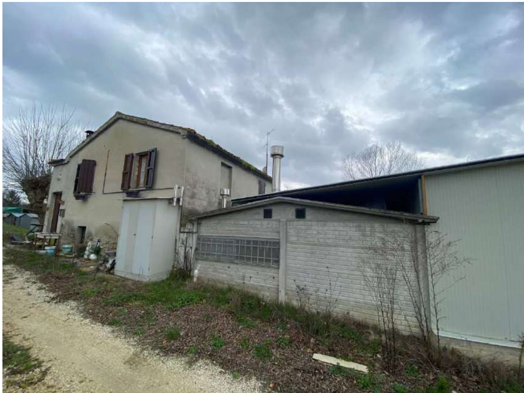
foto 1 - veduta esterna dell'azienda sul lato Est (in primo piano la porzione a capanna in calcestruzzo già condonata)
