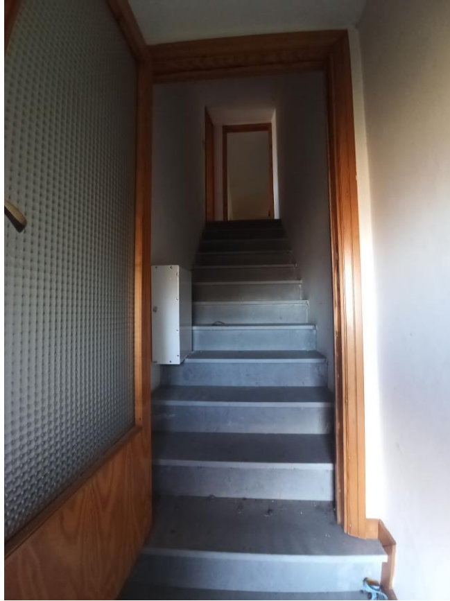
foto 18 – Bene n° 1 – appartamento – piano primo (scala verso il sottotetto)
