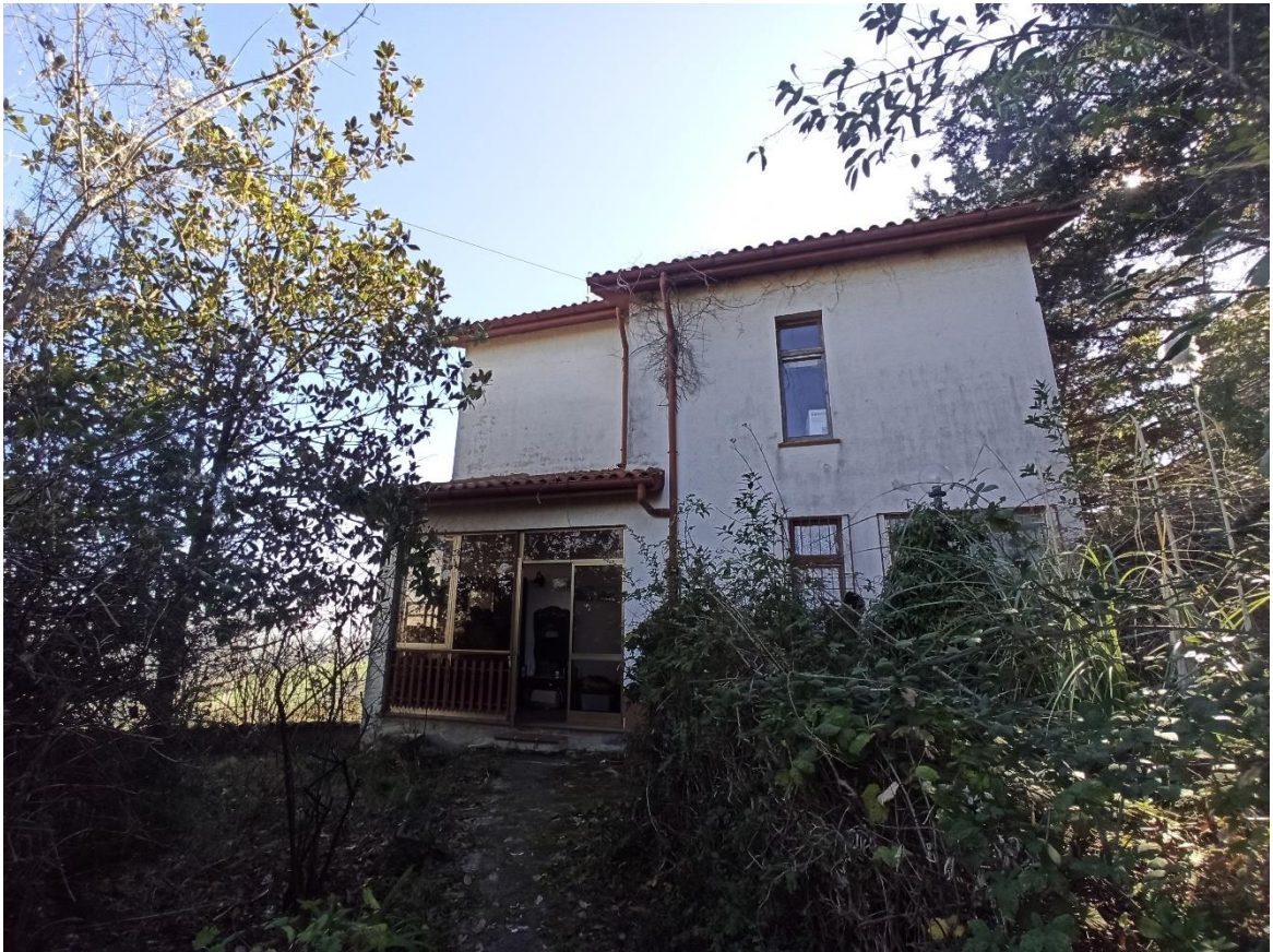
foto 1 – veduta generale del fabbricato da Nord Ovest
