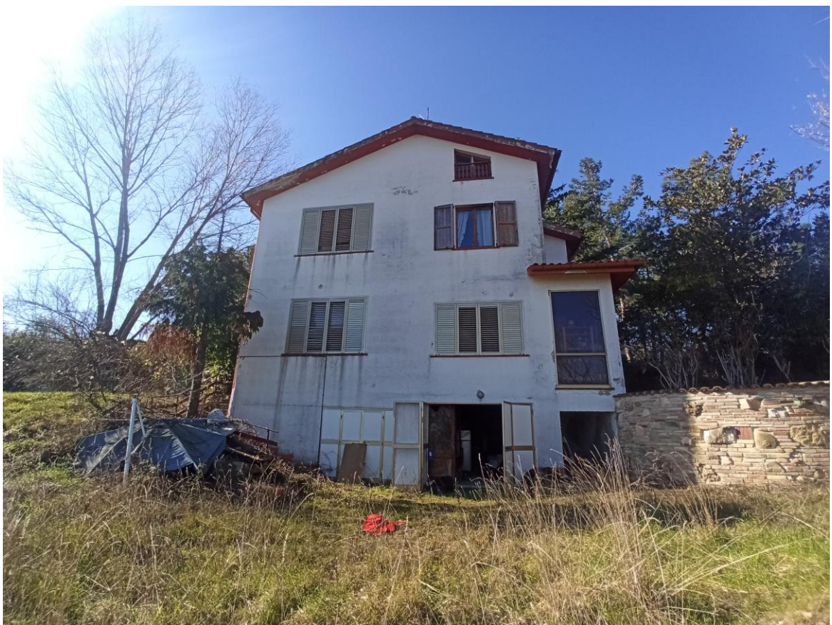
foto 2 – veduta generale del fabbricato da Nord Est
