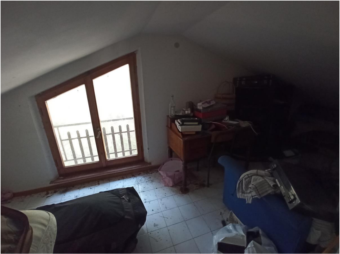
foto 20 – Bene n° 1 – appartamento – piano sottotetto
