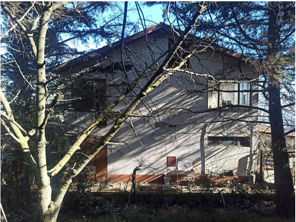
foto 4 – veduta generale del fabbricato da Sud Ovest
