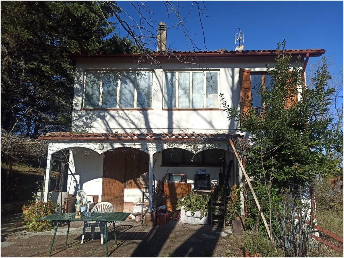
foto 3 – veduta generale del fabbricato da Sud Est
