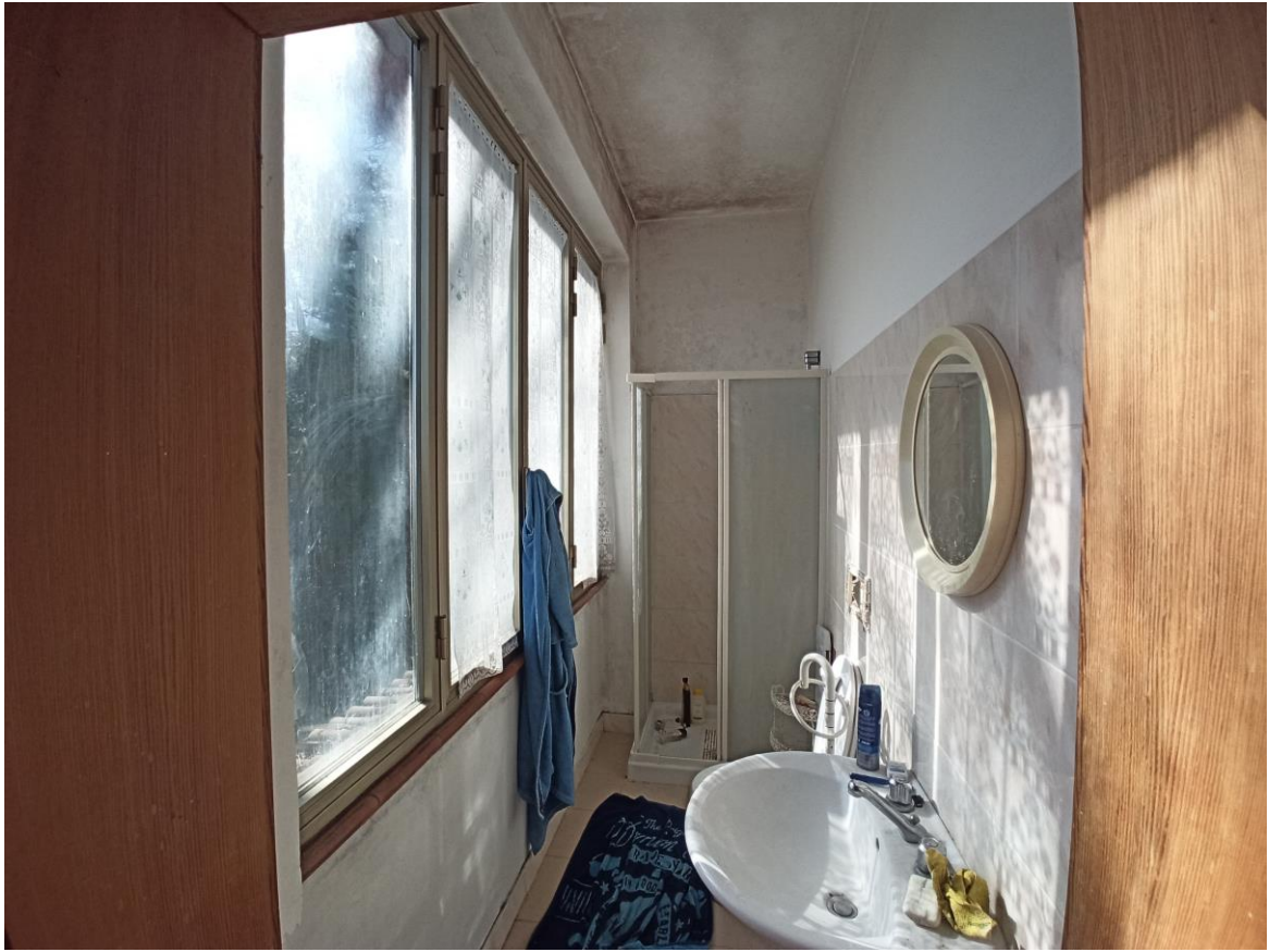
foto 15 – Bene n° 1 – appartamento – piano primo (bagno 2)
