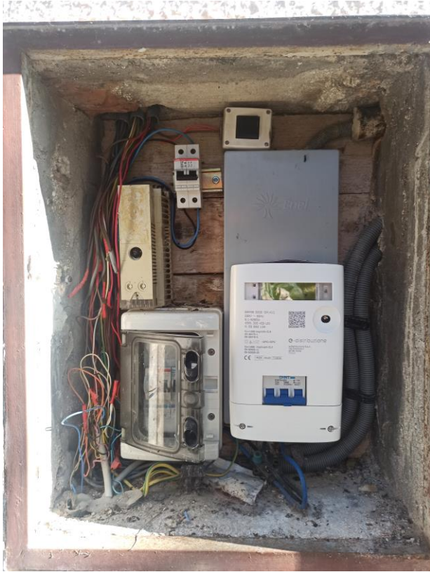
foto 23, 24 – Bene n° 1 – dotazioni impiantistiche: contatore ENEL e quadro elettrico
