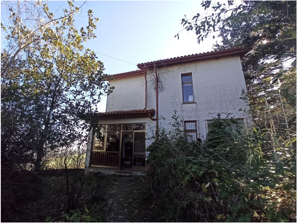
foto 1 – veduta generale del fabbricato da Nord Ovest
