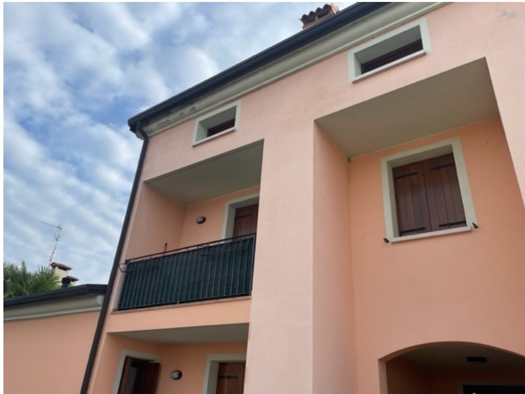
Dettaglio Poggiolo facciata di lato
