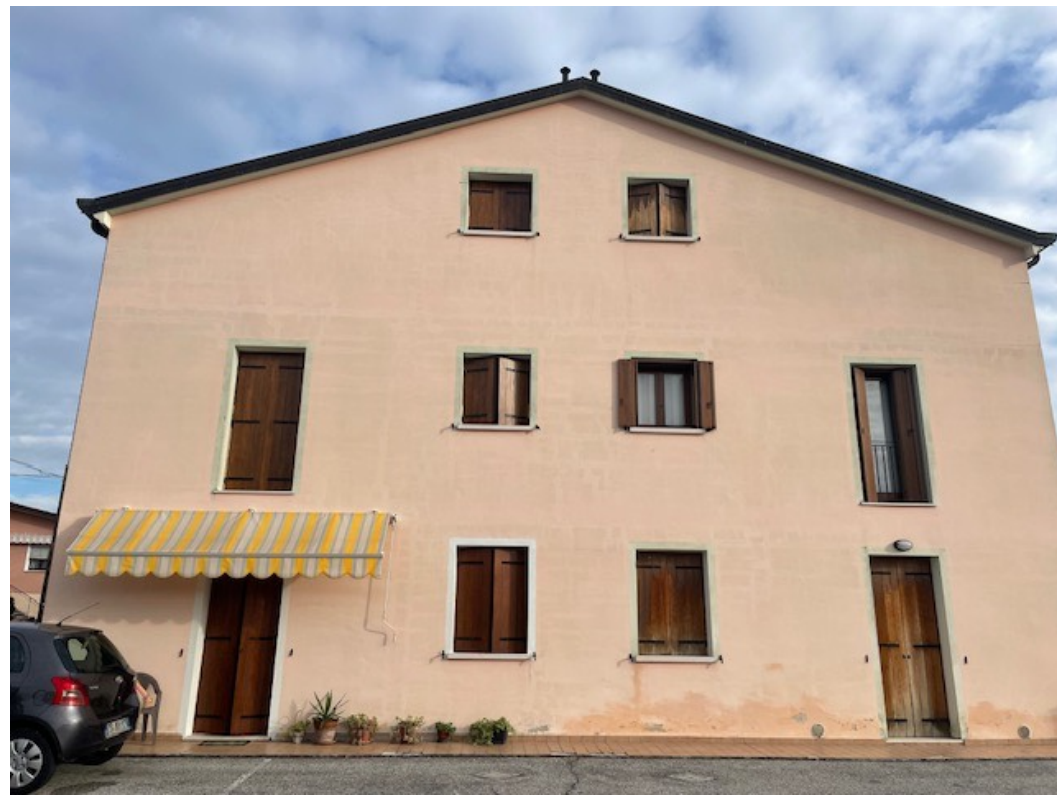
Vista esterna dell'immobile, facciata fronte via Postumia
