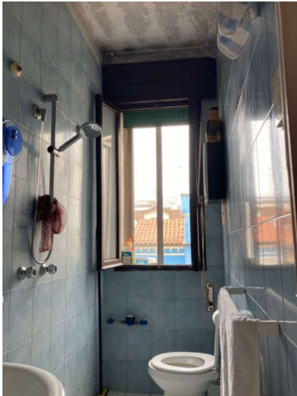
FOTO 10 - Unità al piano terzo. Il bagno.
