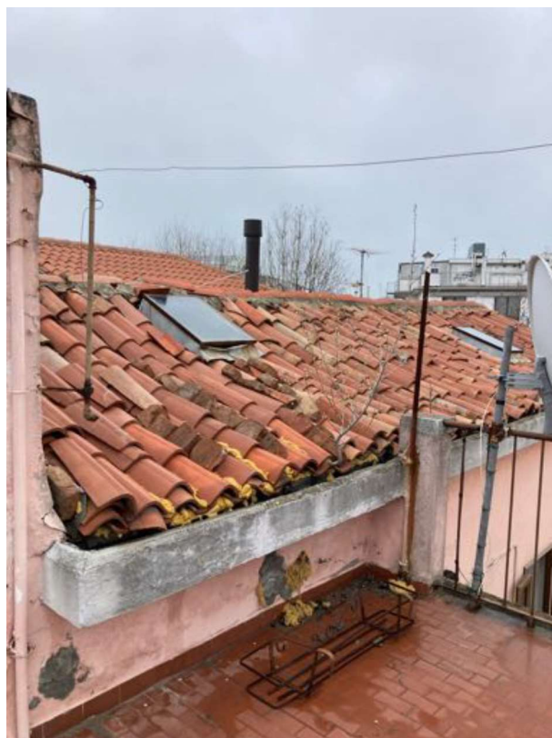
FOTO 12 - La copertura e la terrazza.
