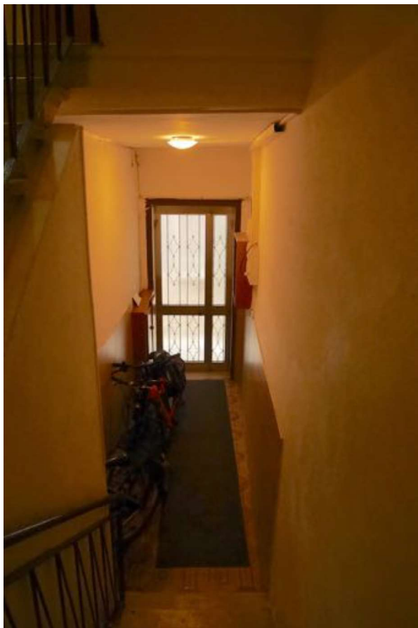
FOTO 4 - Interno. L'ingresso comune.
