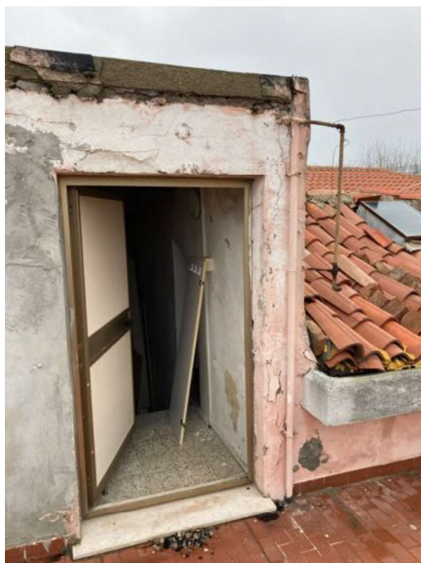
FOTO 13 - L'accesso alla terrazza.
