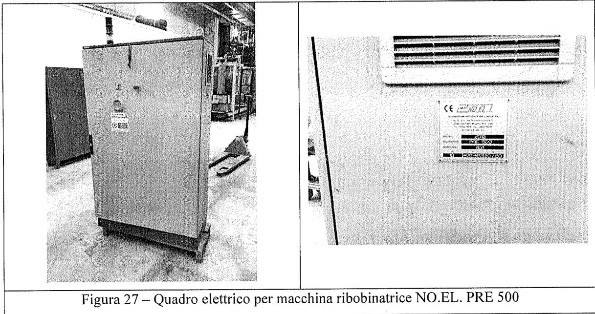
Figura 27 – Quadro elettrico per macchina ribobinatrice NO.EL. PRE 500
