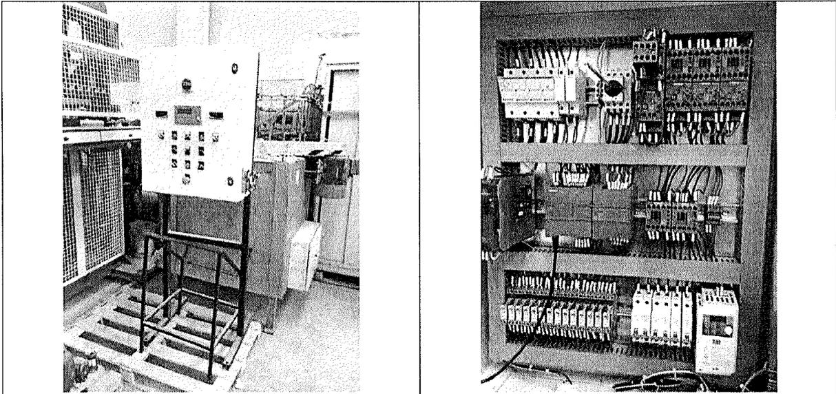
Figura 12 – Quadro di comando. Elementi SIEMENS con armadio in lamiera ETA S.p.A.
