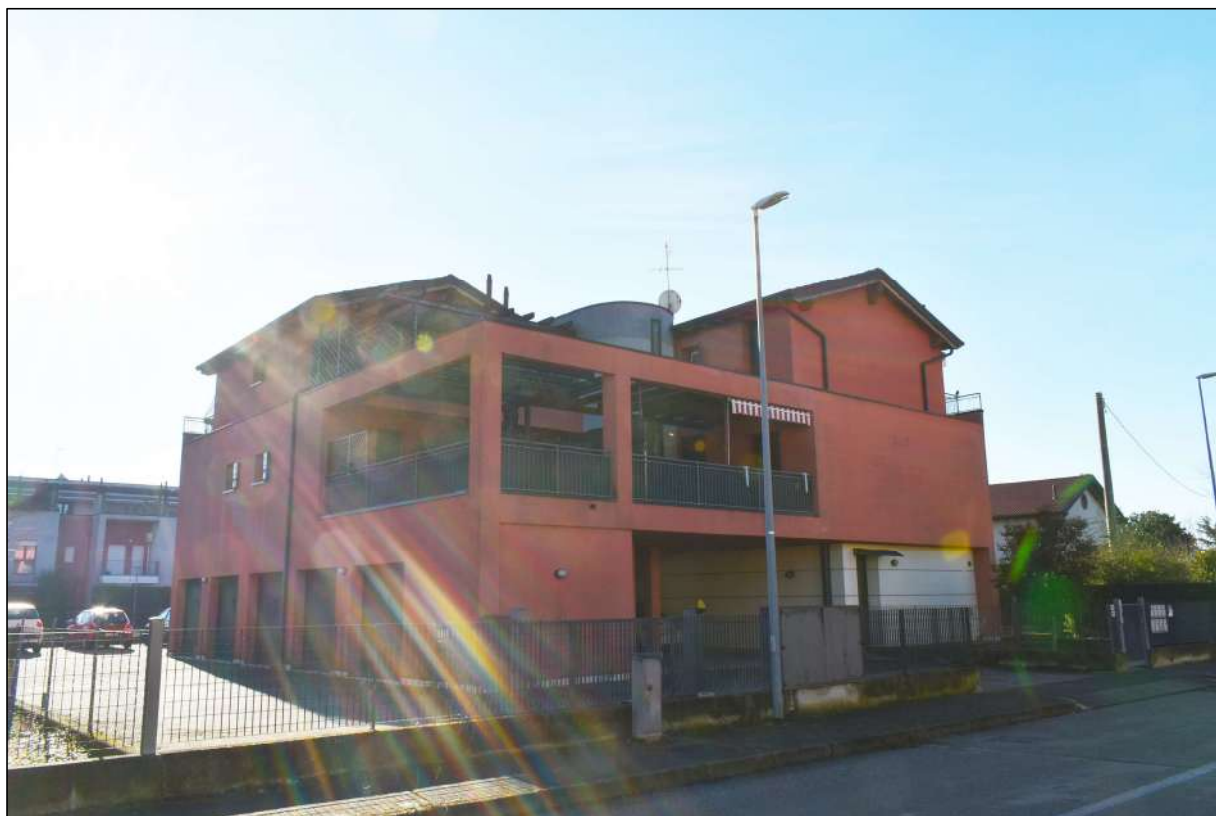
foto 01 - vista complessiva del "Condominio Stella"
