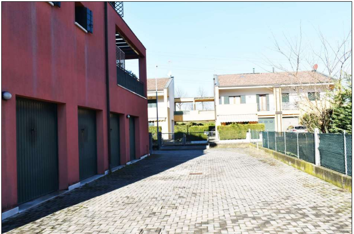
foto 03 - area scoperta condominiale
