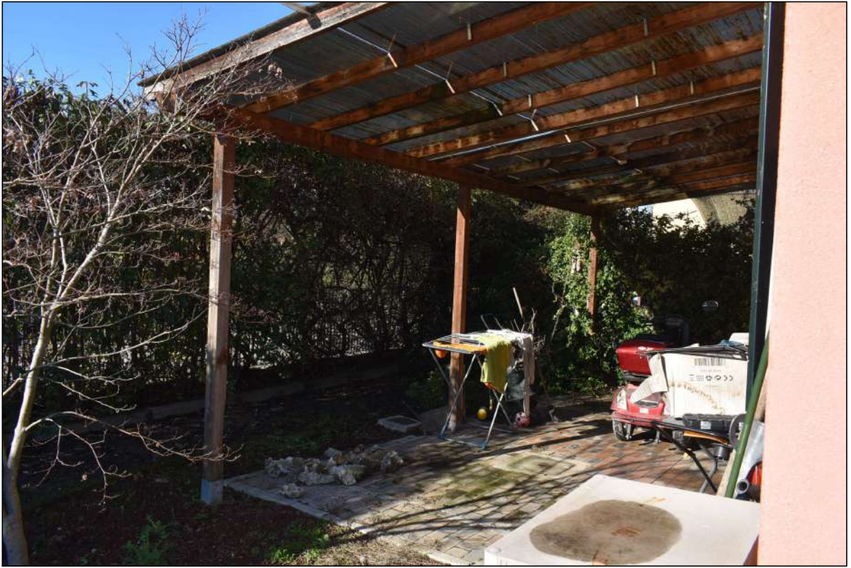
foto 12 - area esterna con porticato
