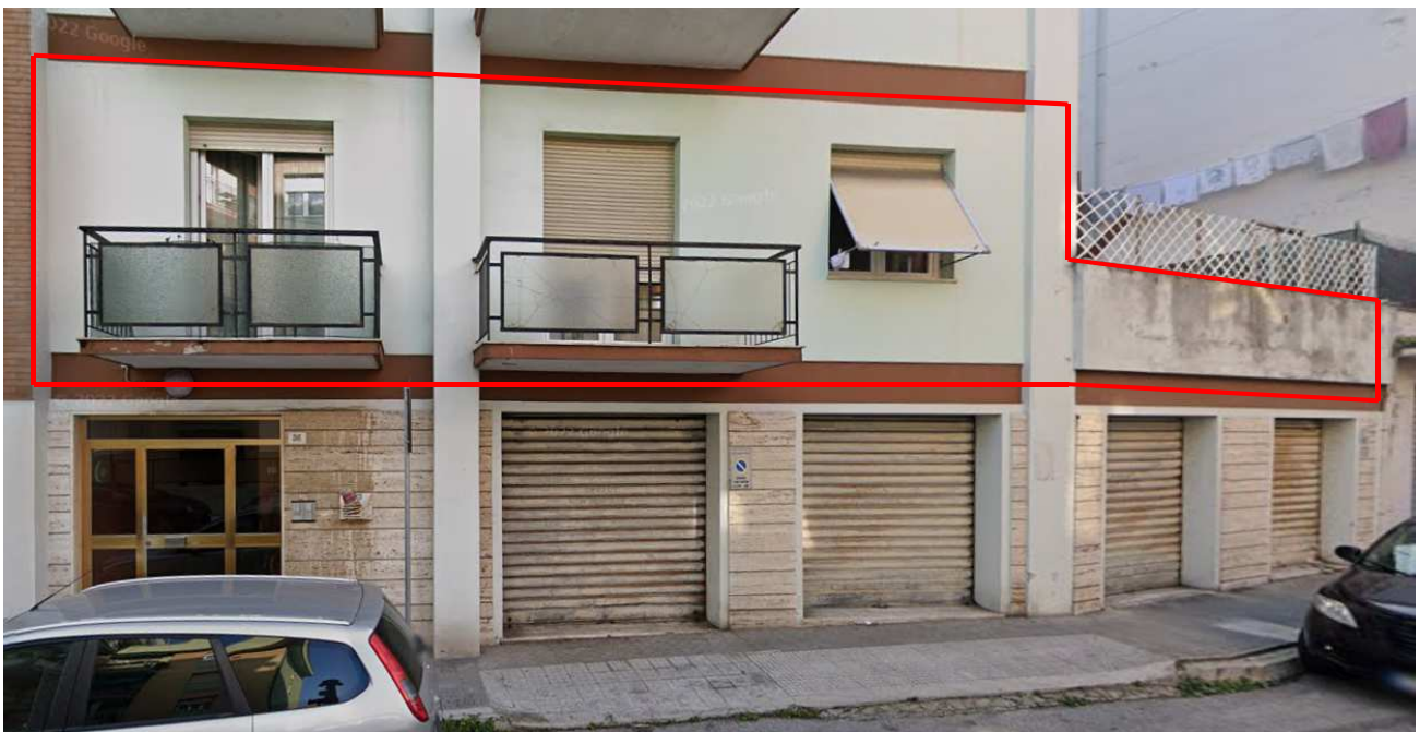
Foto 10 – lato dell'appartamento su via Cingoli
