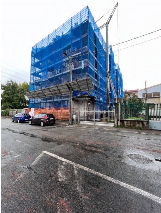
Immagini 1 e 2. Il fabbricato visto dall'esterno; il ponteggio è relativo a lavori di efficientamento energetico mediante la realizzazione di un cappotto esterno.
