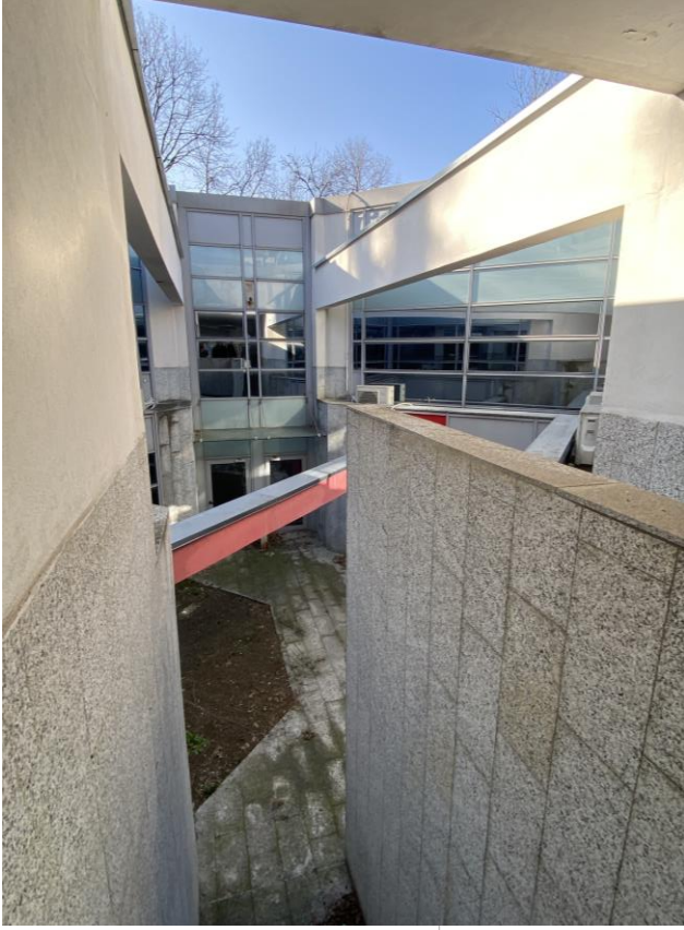
VISTA VERSO IL PATIO APERTO AL SEMINTERRATO
