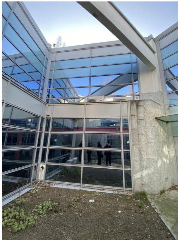
VISTA DEL PATIO-CAVEDIO
