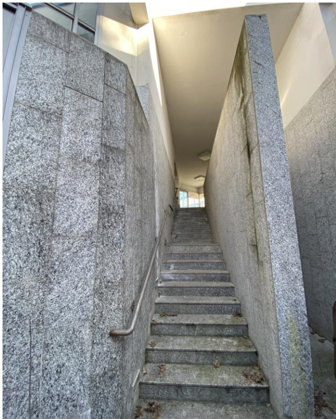
VISTA DAL VANO SCALE
