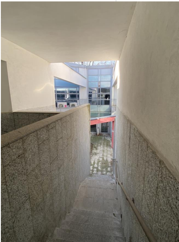
VISTA RAMPA SCALA AL PIANO SEMINTERRATO
