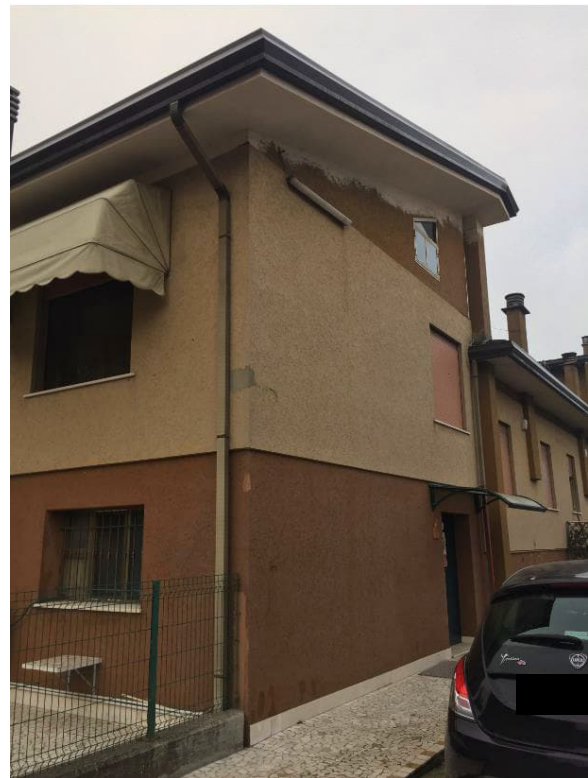
Scoperto su lato nord
