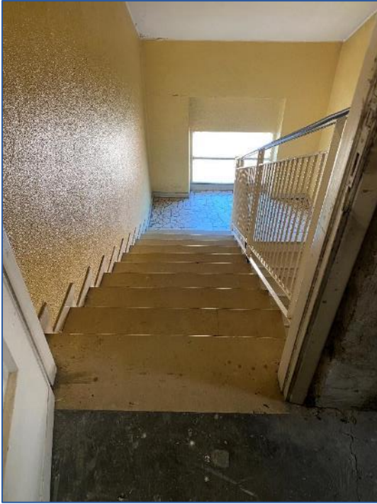
Foto 7 - vano scala comune
