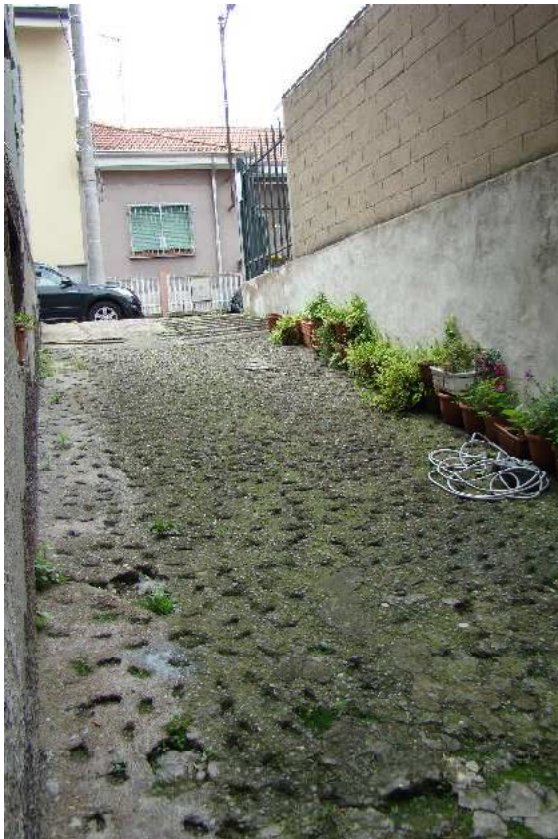
19. Rampa di accesso dalla strada per il piano cantinato.
