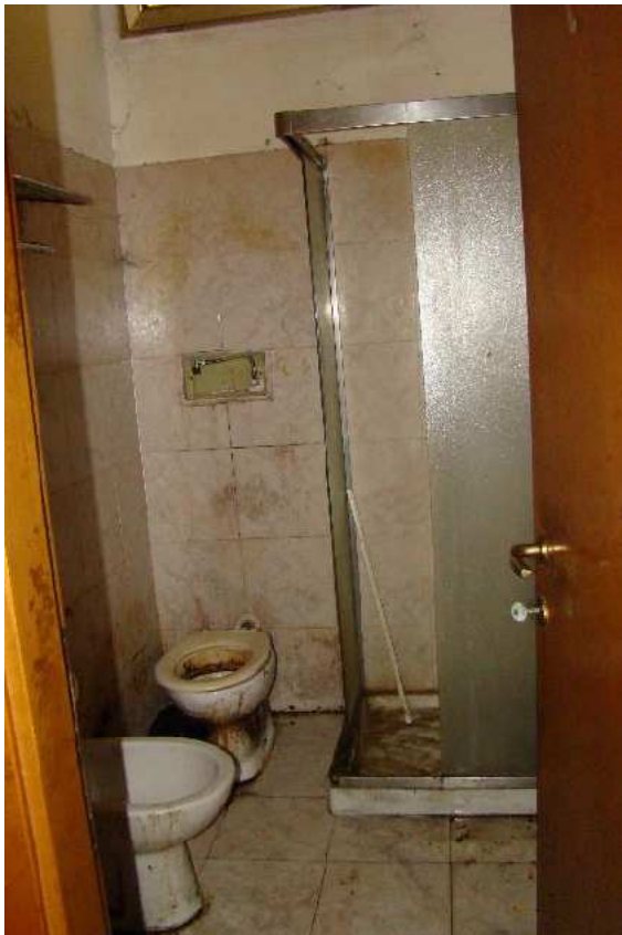
13. Vista del bagno.
