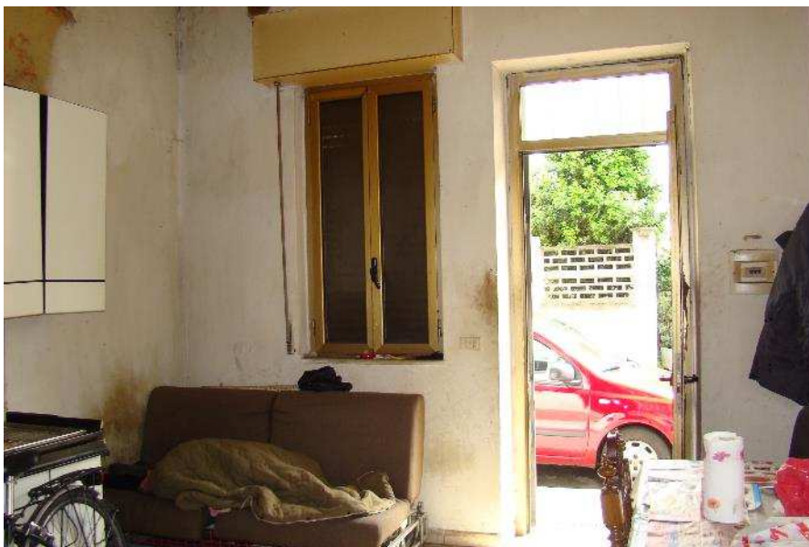
8. Vista dall'interno dell'accesso su strada.
