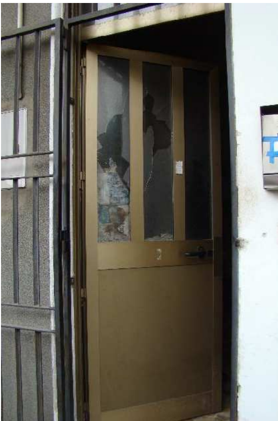
6. Dettaglio dell'ingresso su strada.
