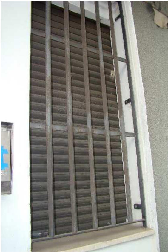
7. Dettaglio della finestra su strada.
