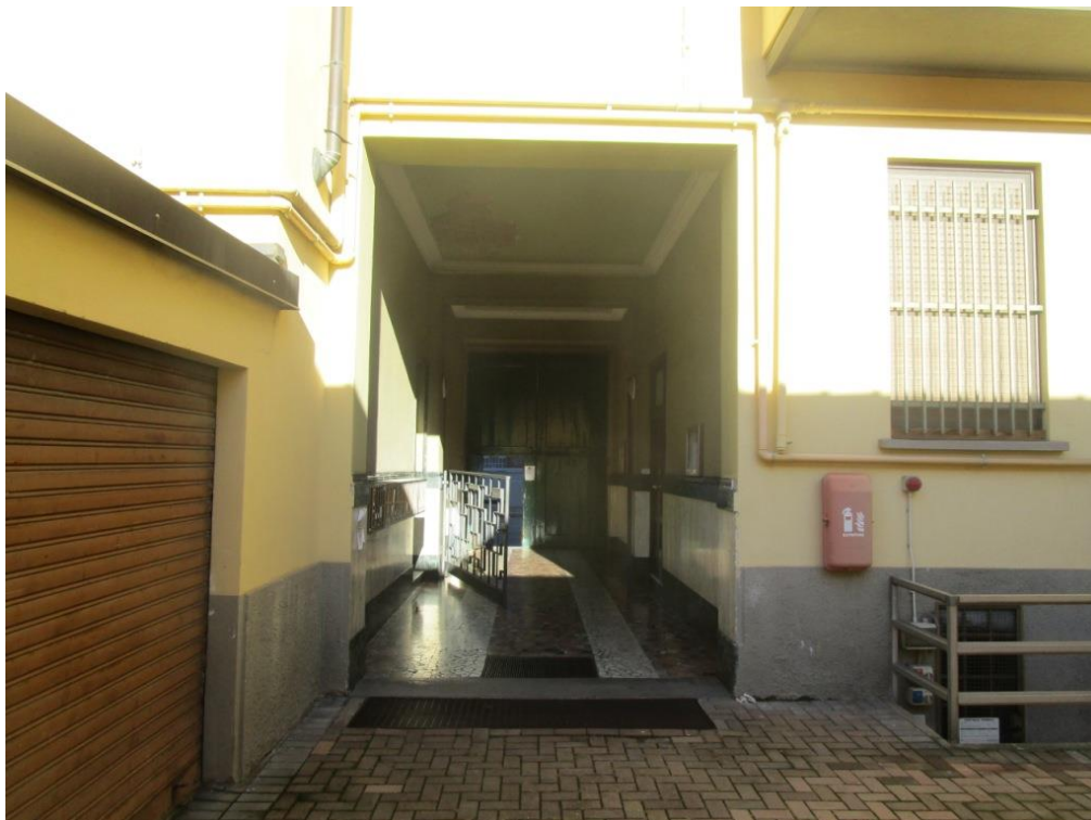
Foto 4 – Vista dal cortile interno verso l'ingresso
