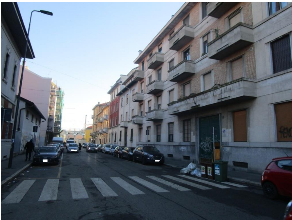
Foto 2 – Vista da via Gallura del complesso condominiale
