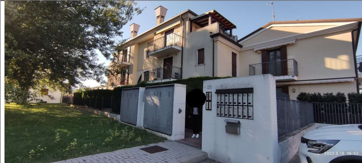
FOTO 1 _INGRESSO CONDOMINALE DALLA VIA SAN MICHELE_ PROSPETTO NORD
