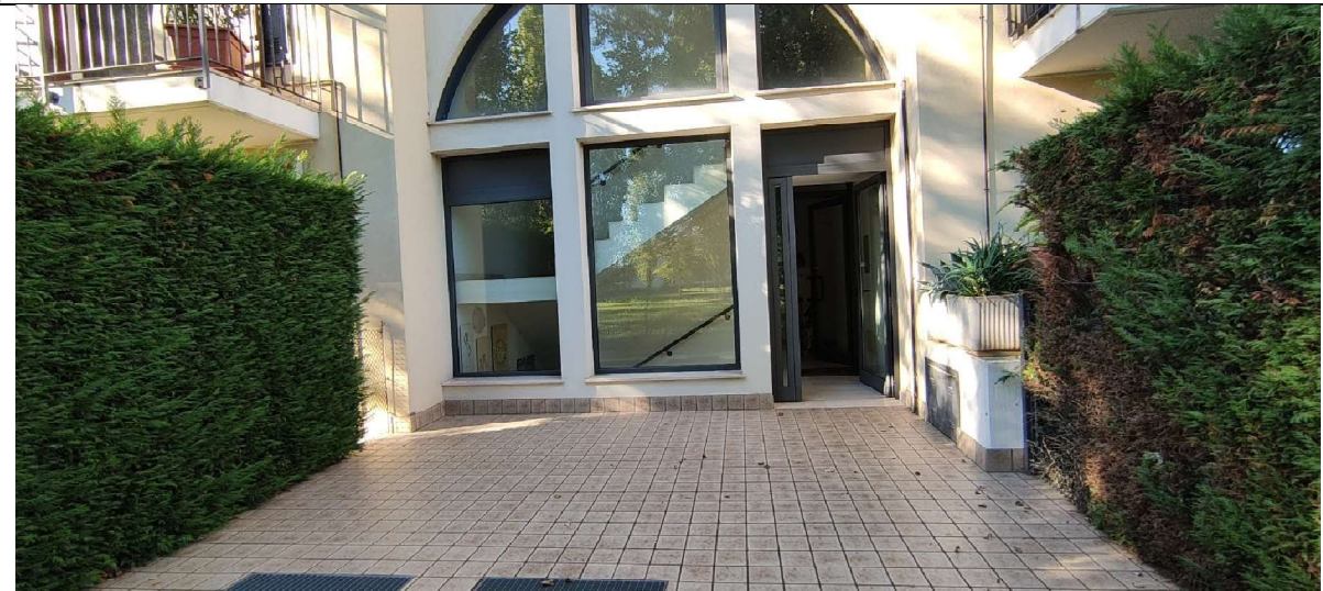
FOTO 2 _PARTICOLARE INGRESSO CONDOMINIALE SU VANO SCALA E ASCENSORE
