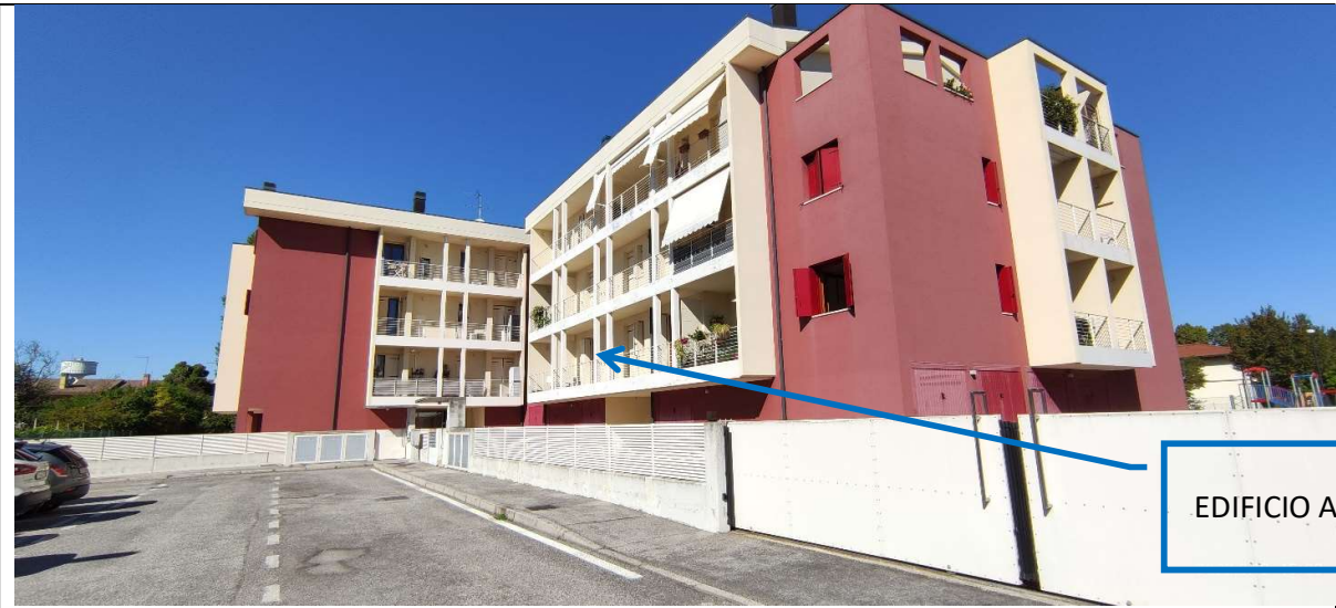
FOTO 1 EDIFICIO CONDOMINIALE_EDIFICI A e B
