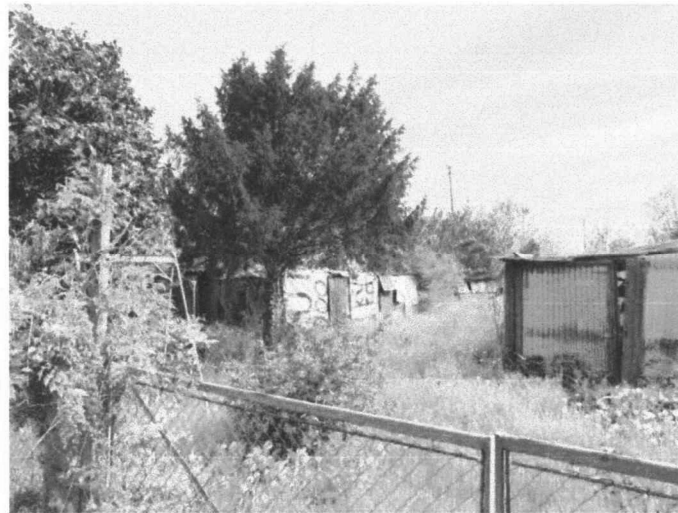
Foto 5: Baracche da demolire
