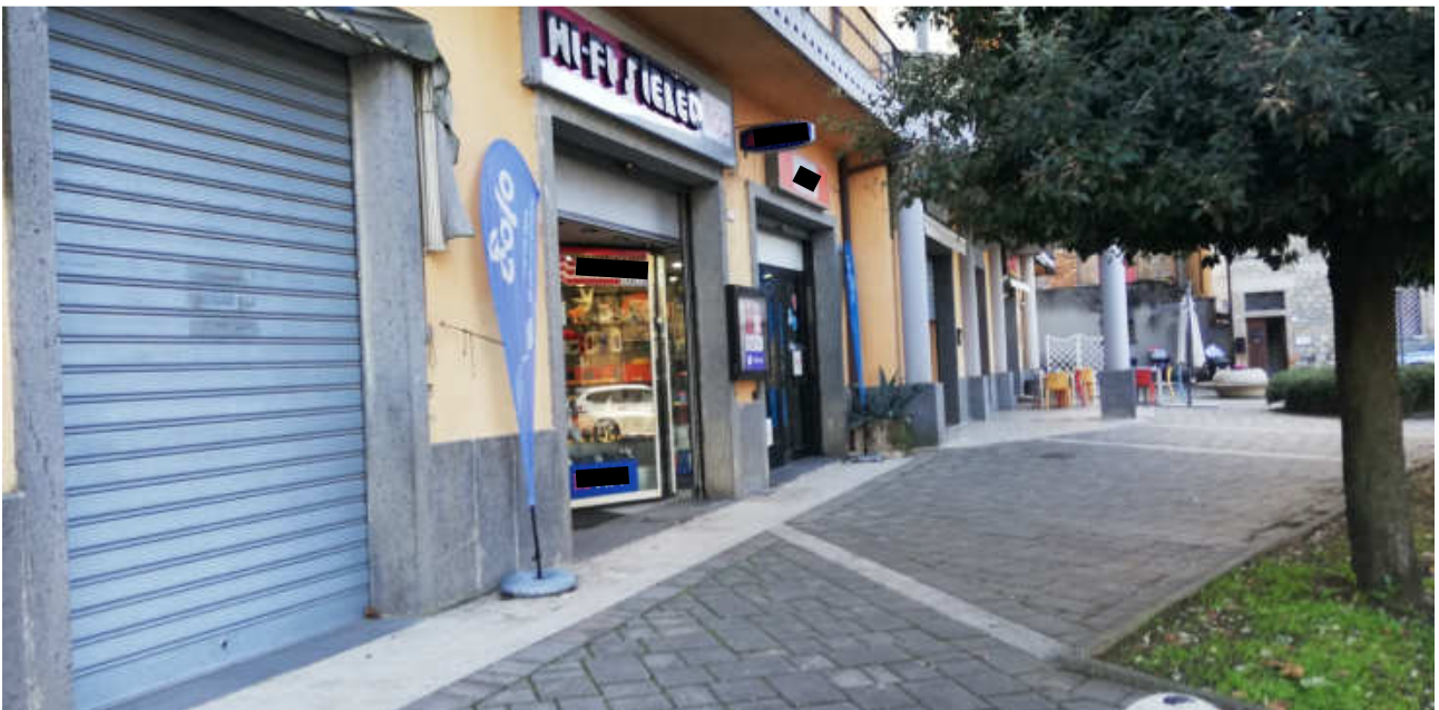
2) ESTERNI: vista da nord dell'immobile, dalla corte condominiale, lungo via Nazionale
