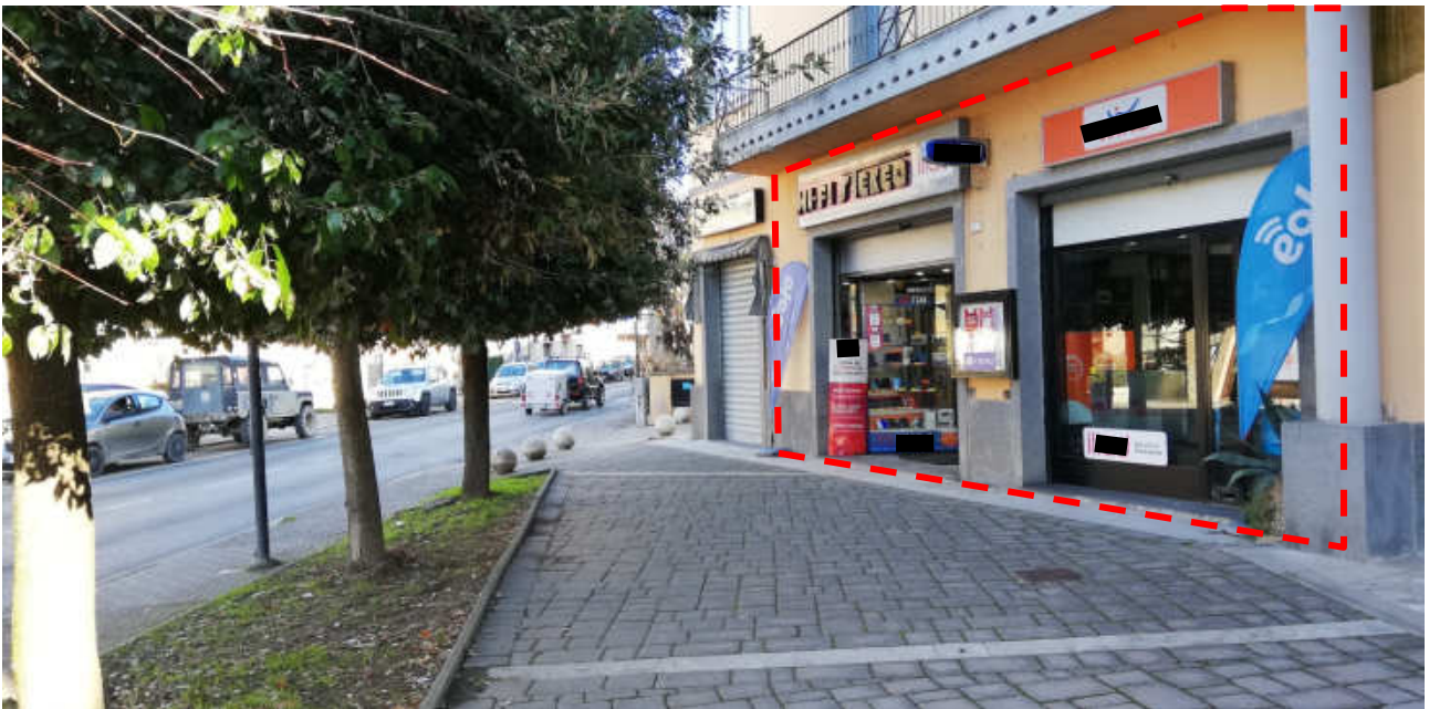
1) ESTERNI: vista da sud dell'immobile dalla corte condominiale, lungo via Nazionale
