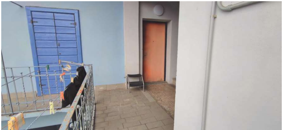
Immagine. 8. Ingresso al piano primo. Vista dal ballatoio di distribuzione.
