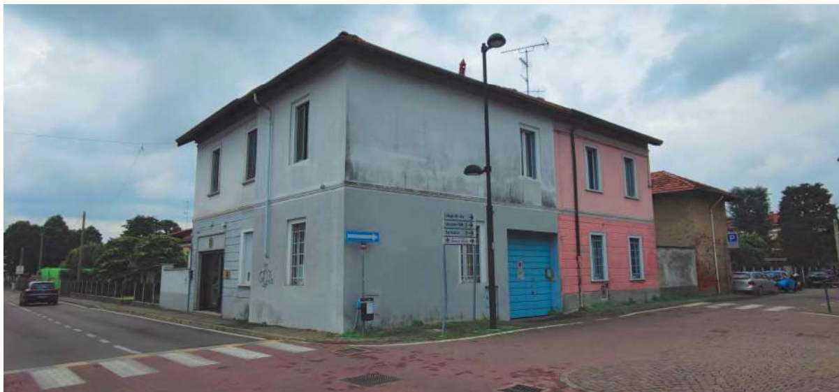
Immagine. 1. Vista da strada
