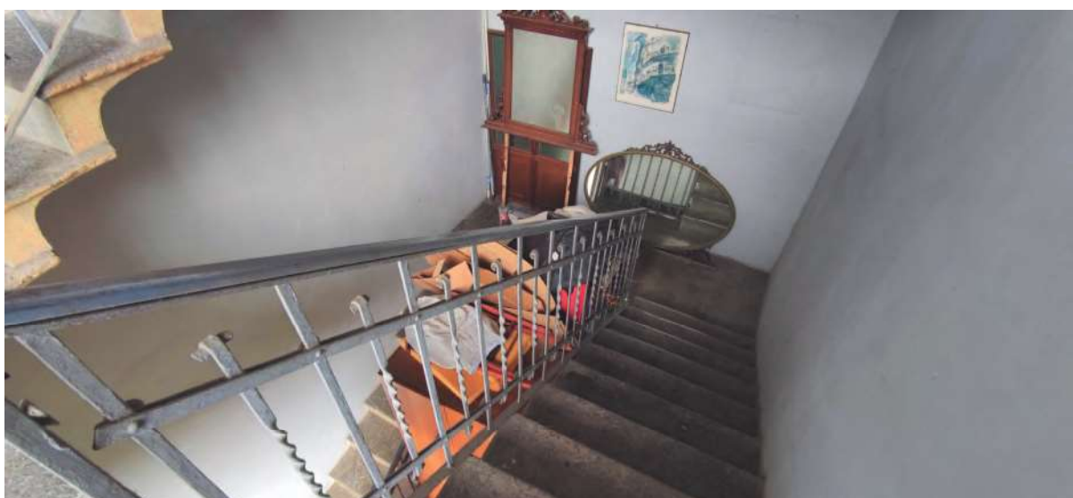
Immagine. 3. Scala comune di accesso al primo piano.
