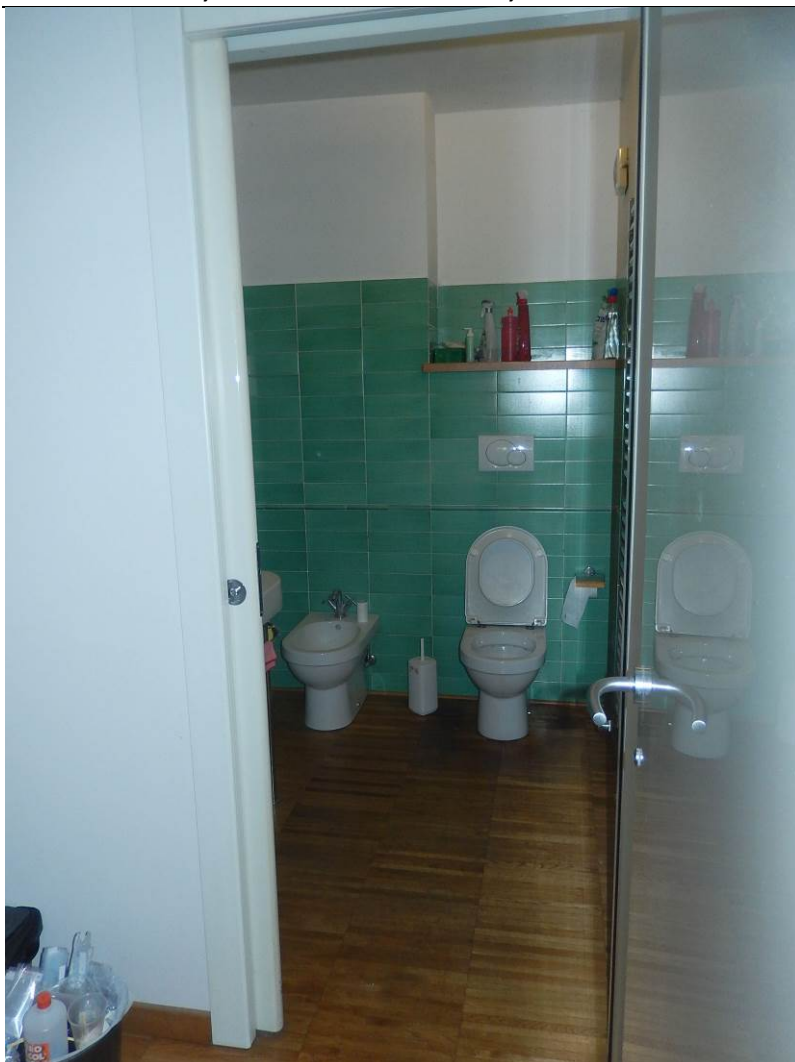
Foto 11 – Il bagno al piano primo.
