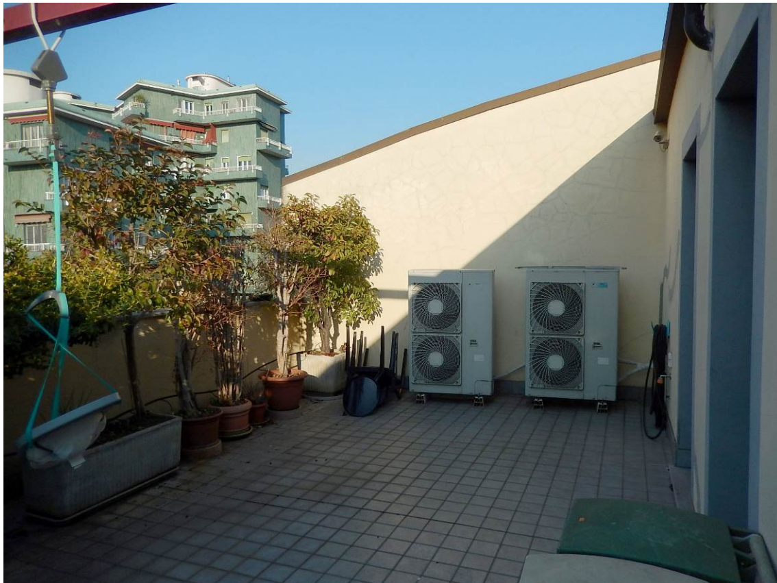
Foto 14 – La terrazza al piano secondo, sul lato nord.
