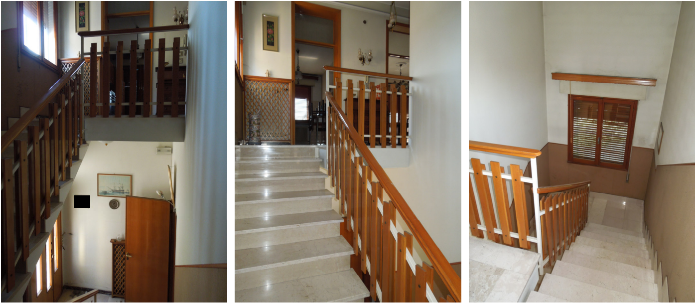
Tre scatti del vano scala dal pianerottolo verso il piano terra (a sinistra) e verso il primo (al centro); a destra dal piano superiore
