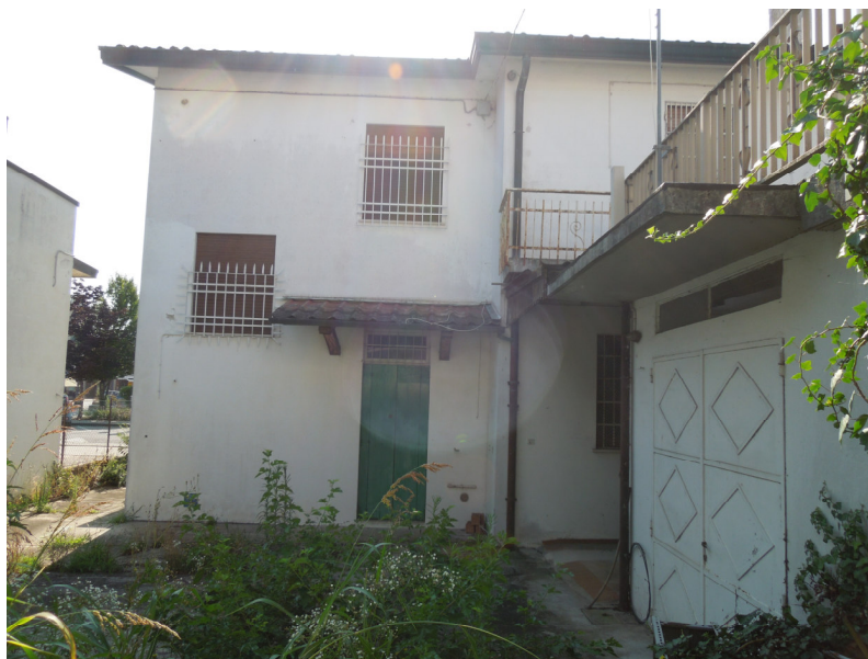
Il prospetto ovest dell'appartamento dallo scoperto (comune al garage visibile sulla destra)
