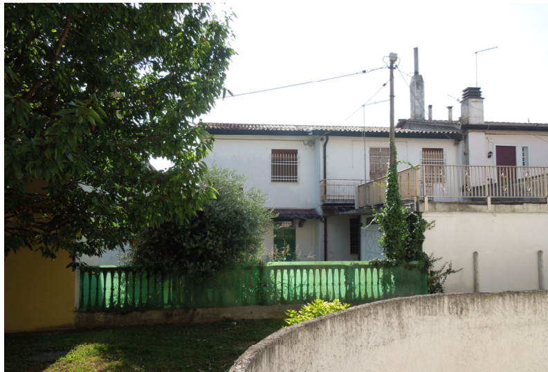
Il prospetto ovest dell'appartamento dalla proprietà contermina
