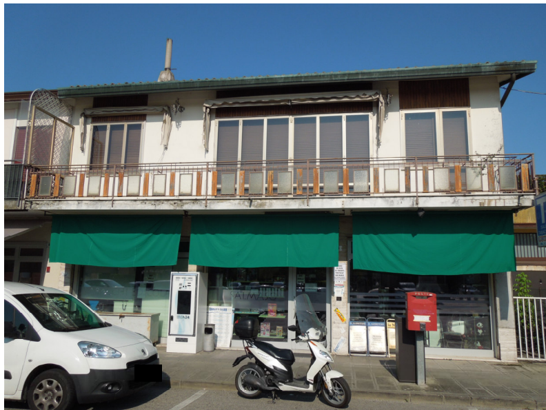
L'affaccio del primo piano dell'appartamento col terrazzo su Piazza San Martino
