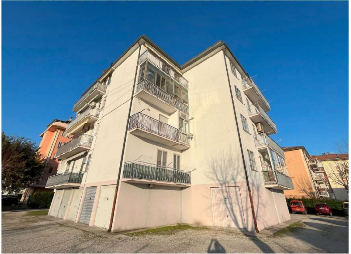
Particolare dei fronti Sud e Ovest
