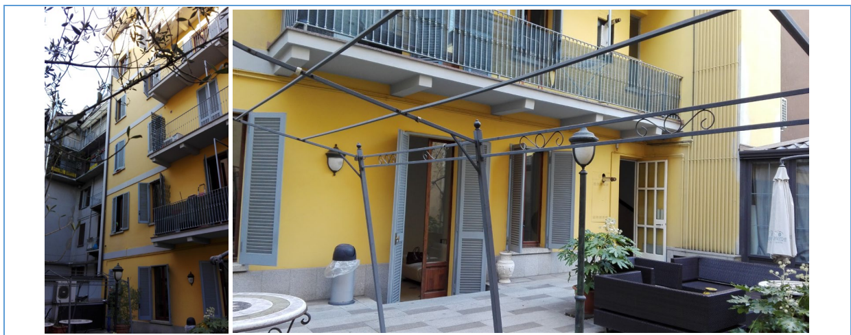
Fig. 6: prospetto vs. cortile interno
