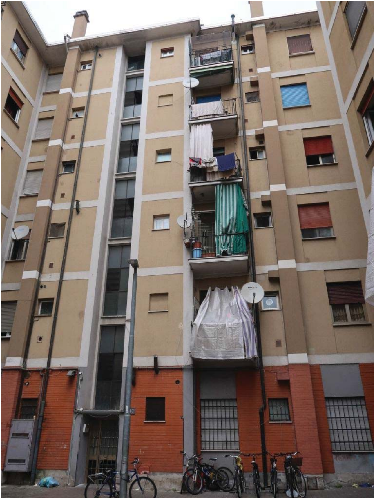
FACCIATA SU CORTILE INTERNO
