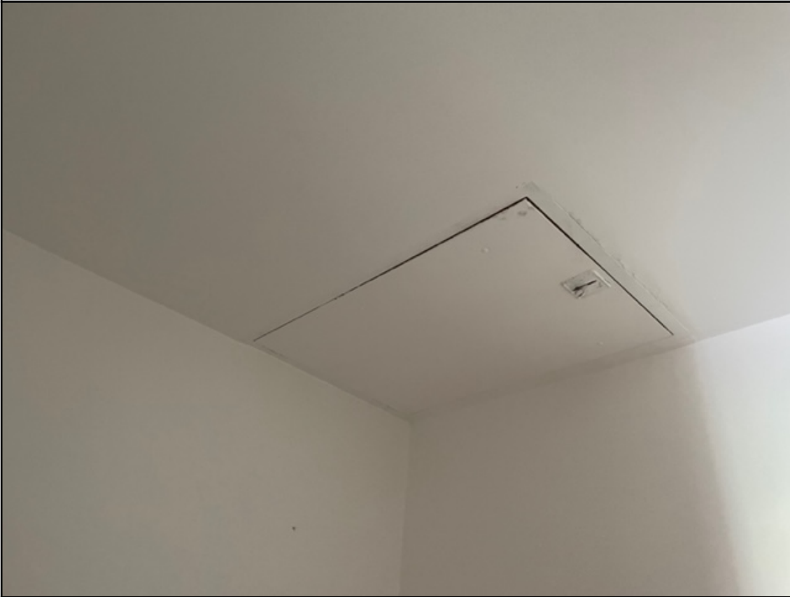
Botola per accesso a soffitta
