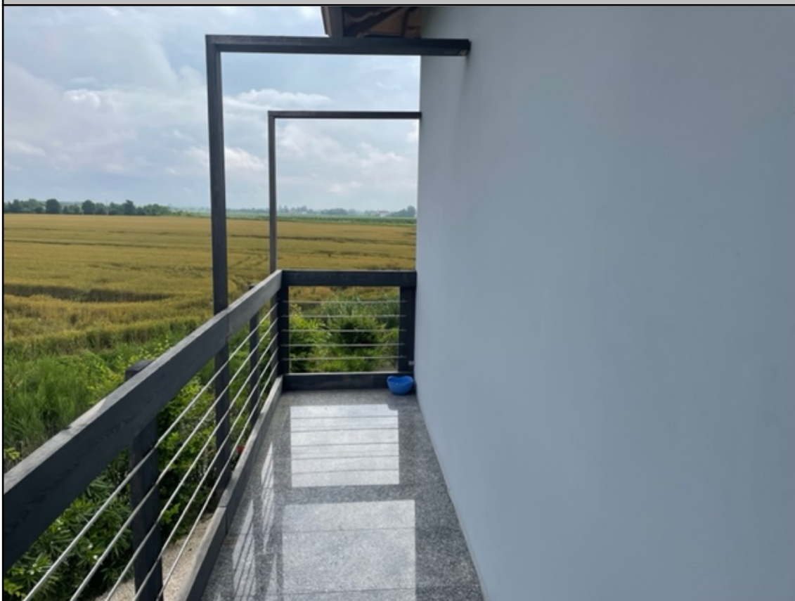
Balcone esterno, lato nord
