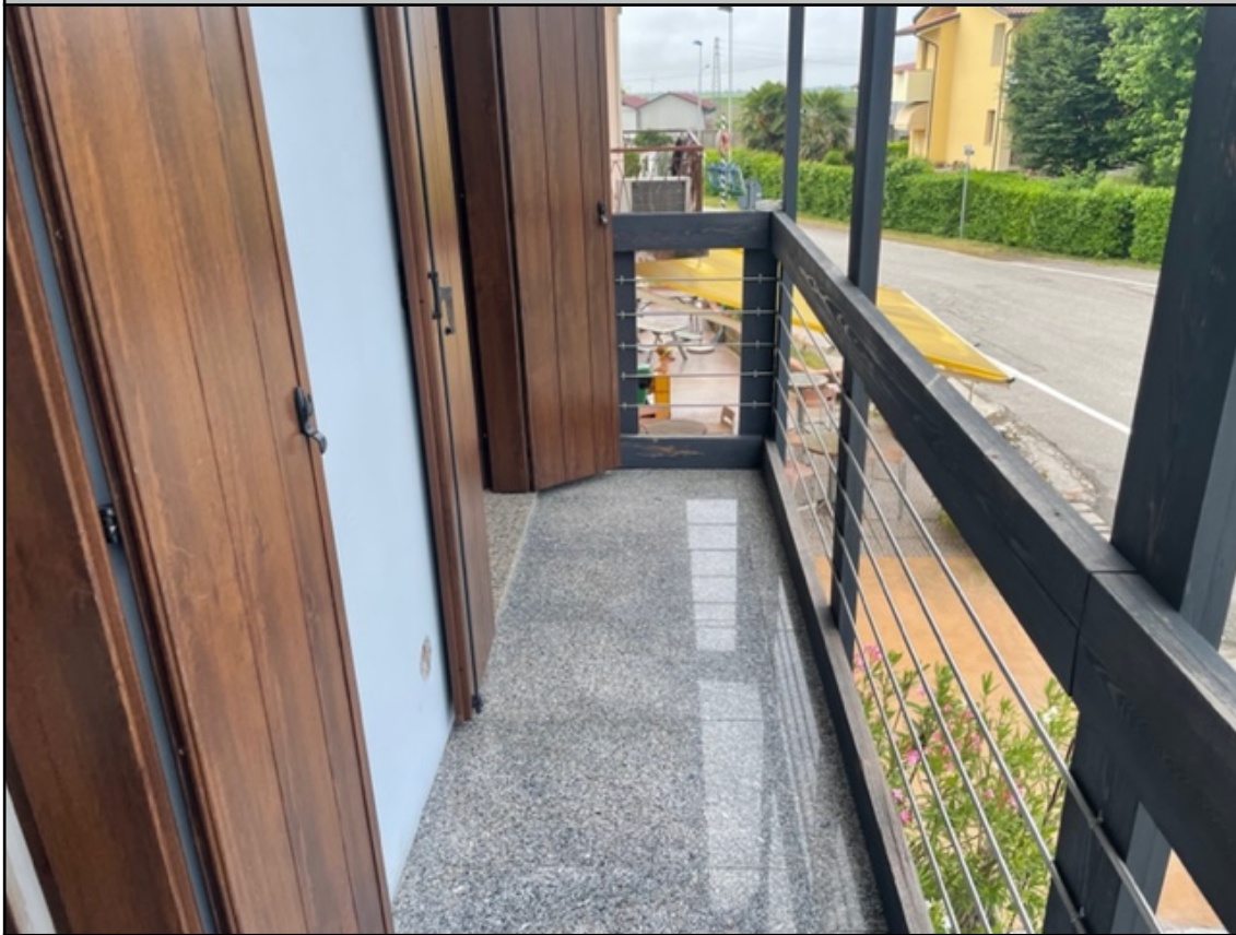
Balcone esterno, lato strada
