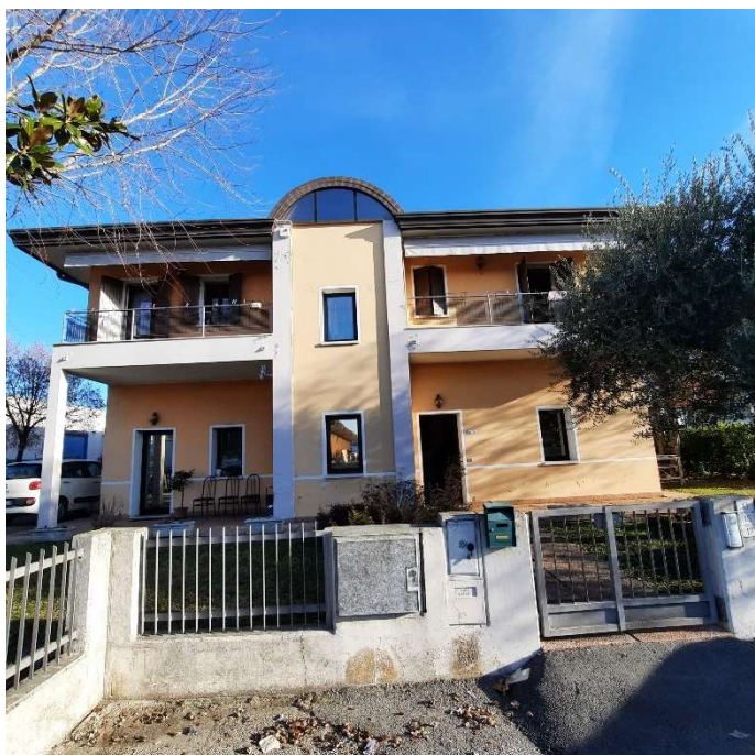
Foto 1 - Prospetto Sud Ovest – Ingresso laboratorio
