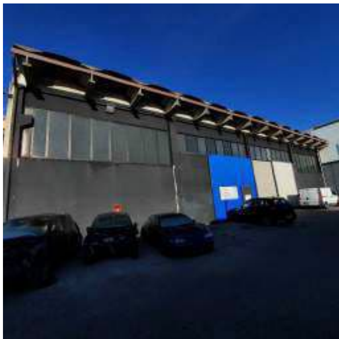
Foto 3 – scorcio prospetto sud est
