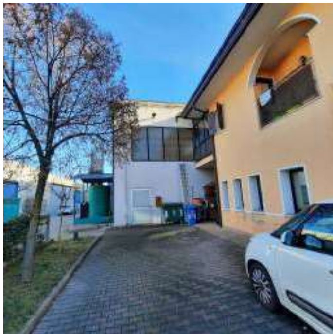
Foto 2 – scorcio prospetto Nord Ovest
