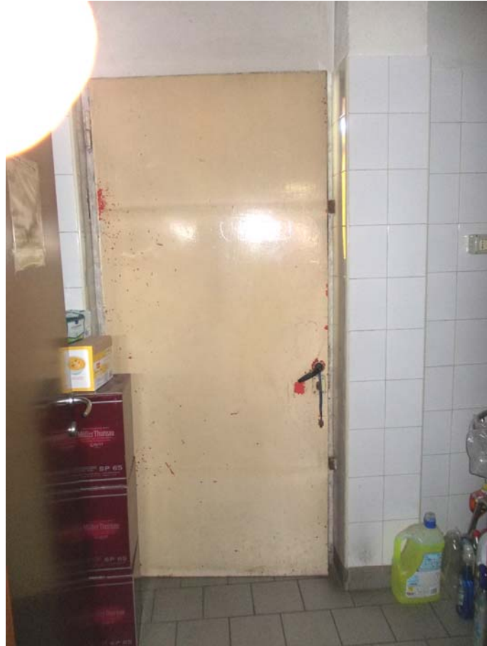
Porta di comunicazione esterna lato cortile
