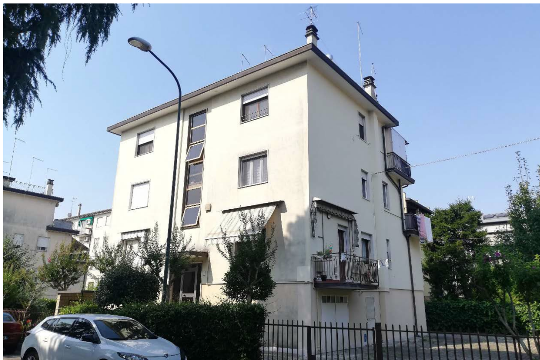
Foto n. 1 Vista del fabbricato da nord-est
