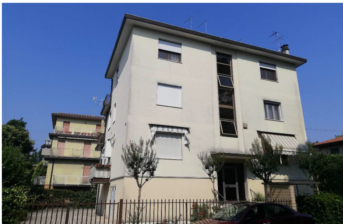
Foto n. 2: vista del fabbricato da sud-est
