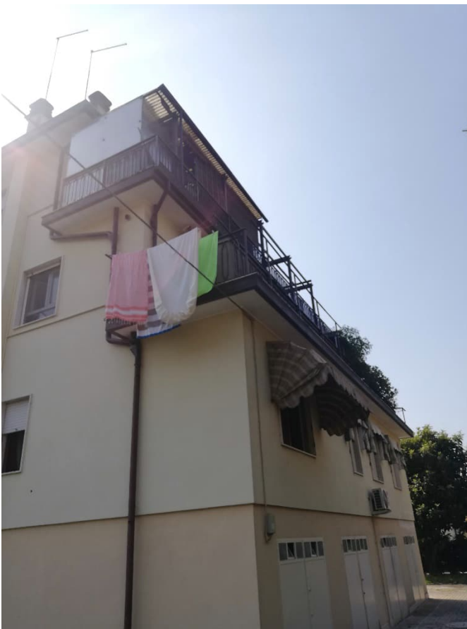
Foto n. 4: Vista del fabbricato- ovest
