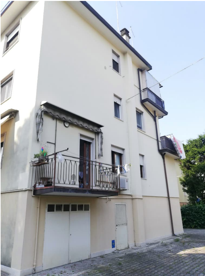
Foto n. 3: vista del fabbricato -nord
