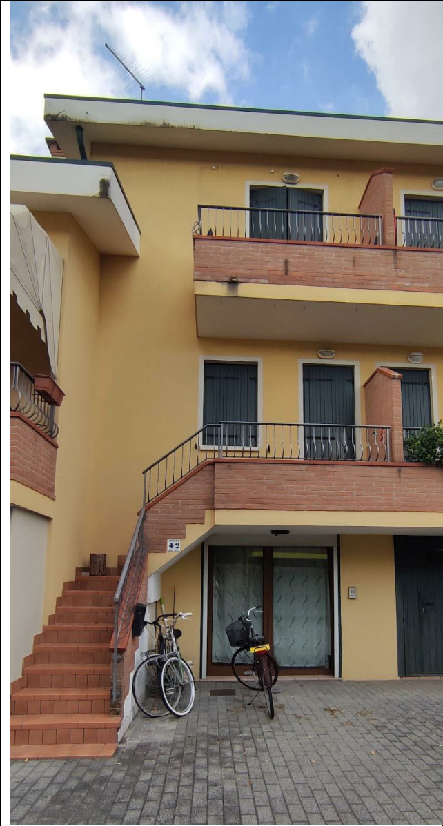
FOTO 1_PROSPETTO SUD OVEST
