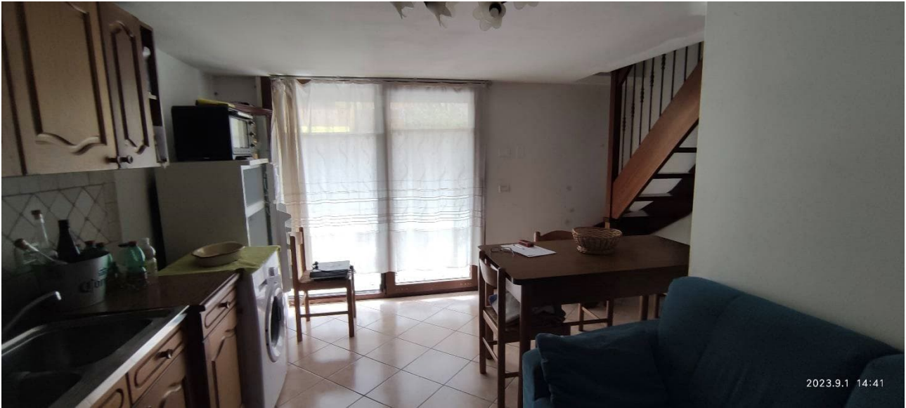
FOTO 3_PIANO TERRA/ AUTORIMESSA UTILIZZATA COME CUCINA/ PARTICOLARE VERSO SUD-OVEST
