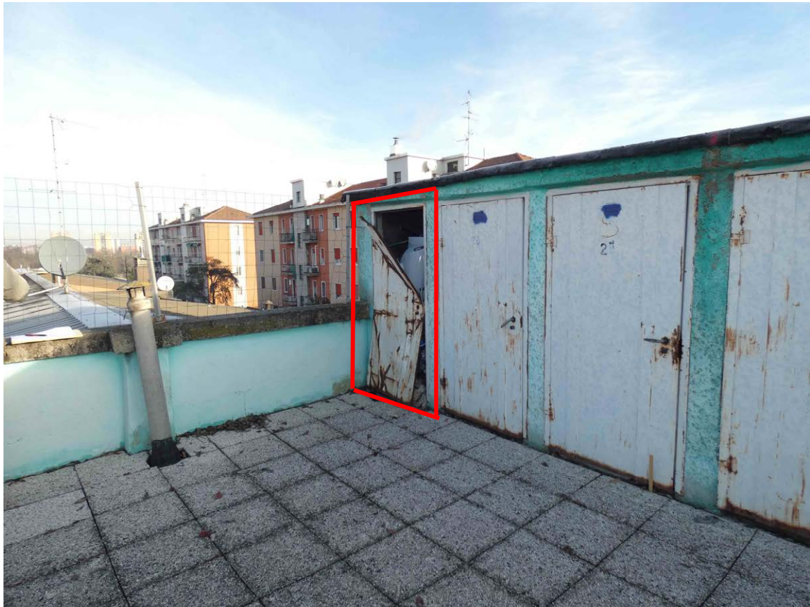
Foto 12. Porta d'accesso al solaio
