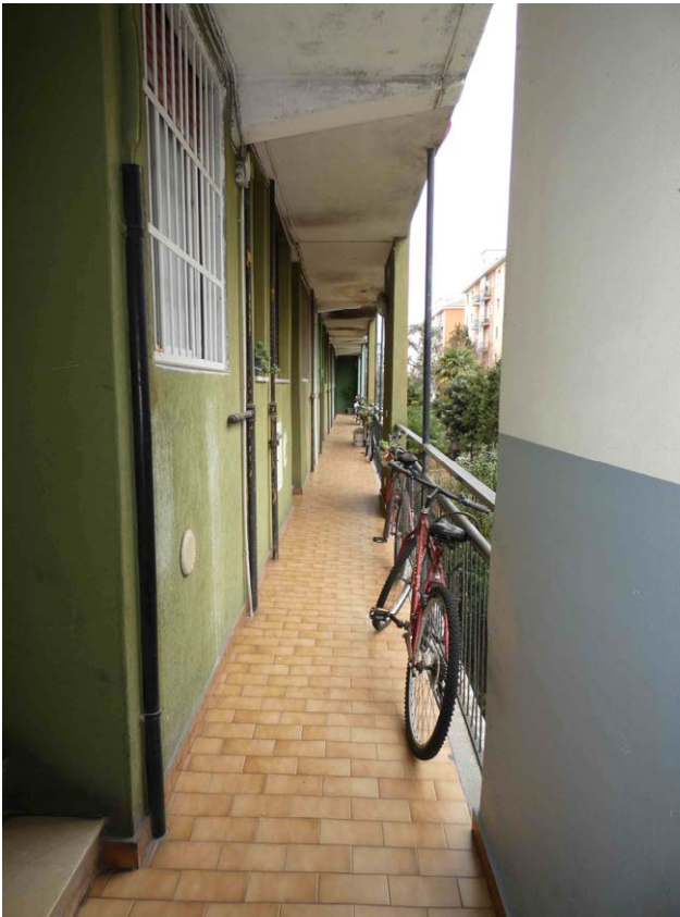
Foto 6. Ballatoio comune piano primo
