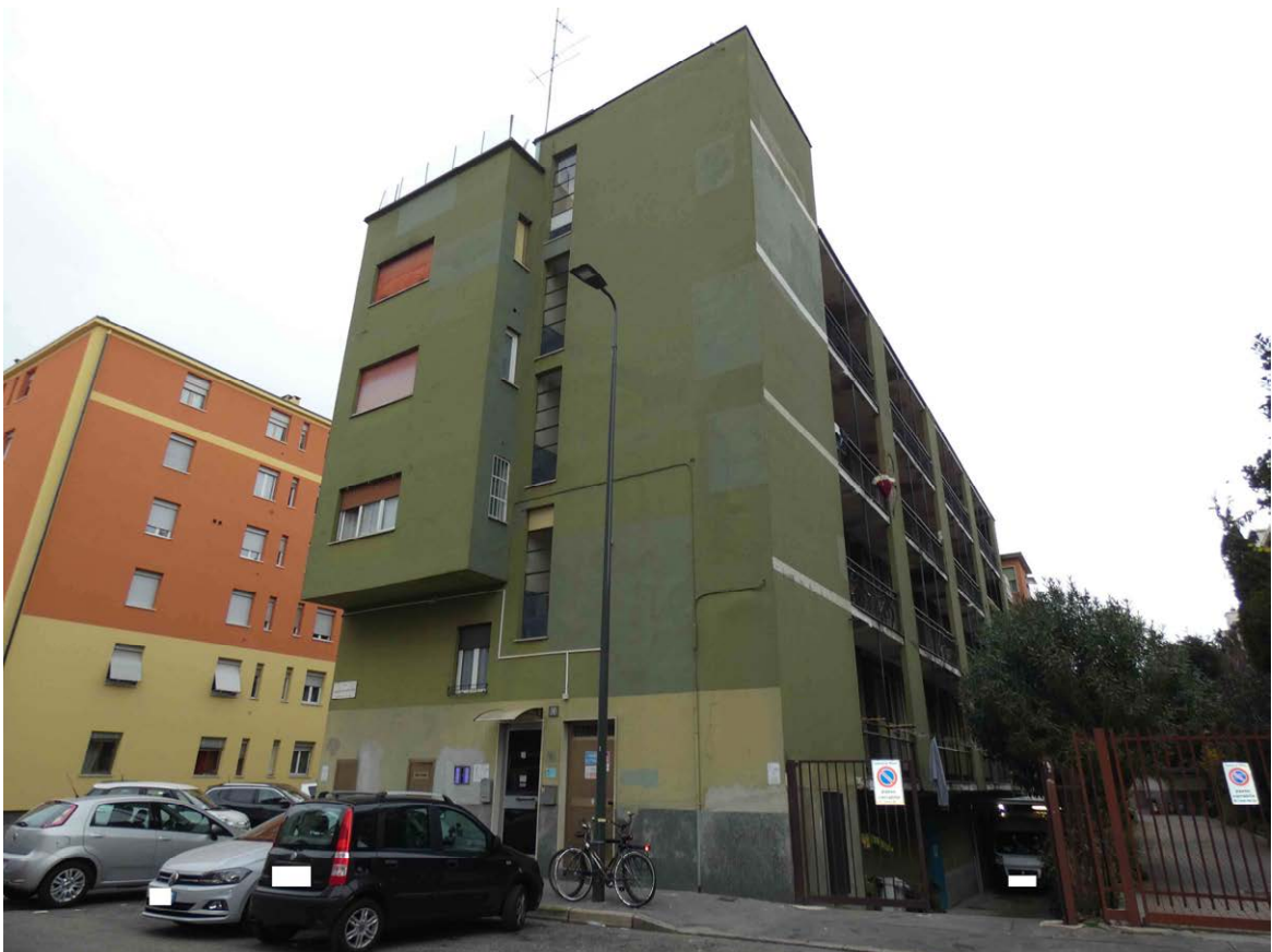
Foto 2. Prospetti su Via Marta Navarra Bernstein e cortile oltre ad accesso carraio
