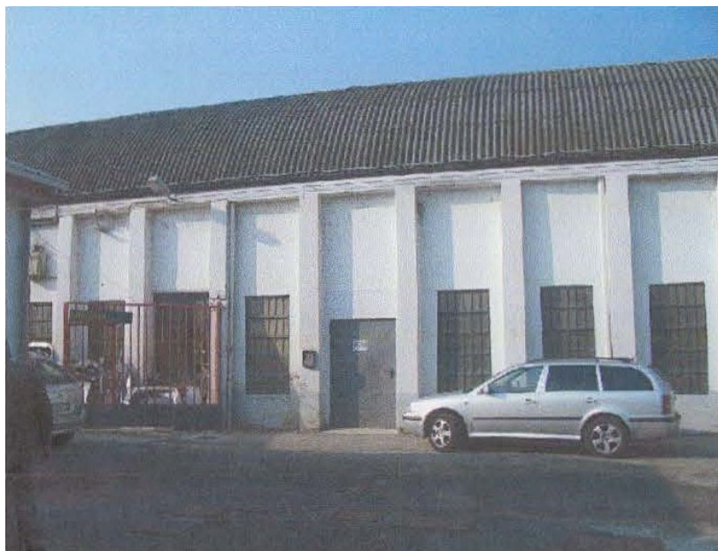
Foto ante lavori 2006/2015
