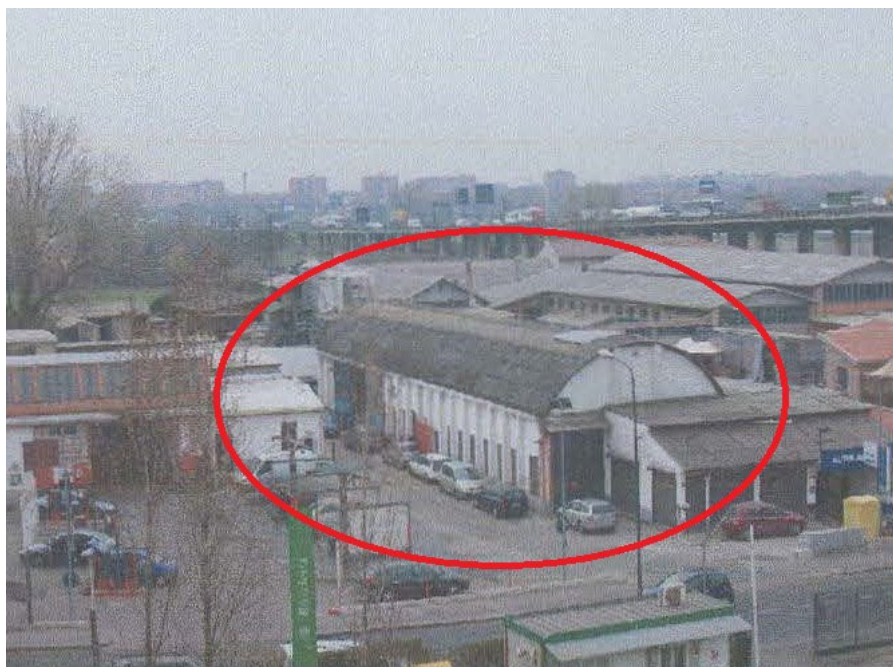
Foto ante lavori 2006/2015
