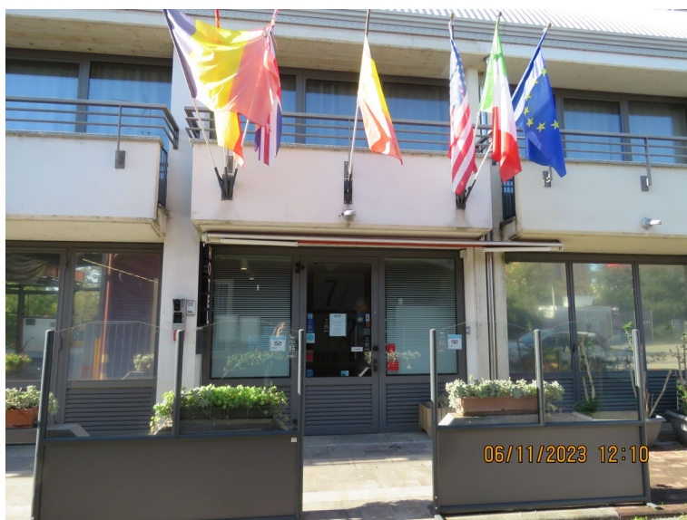
Foto post lavori 2006/2015
