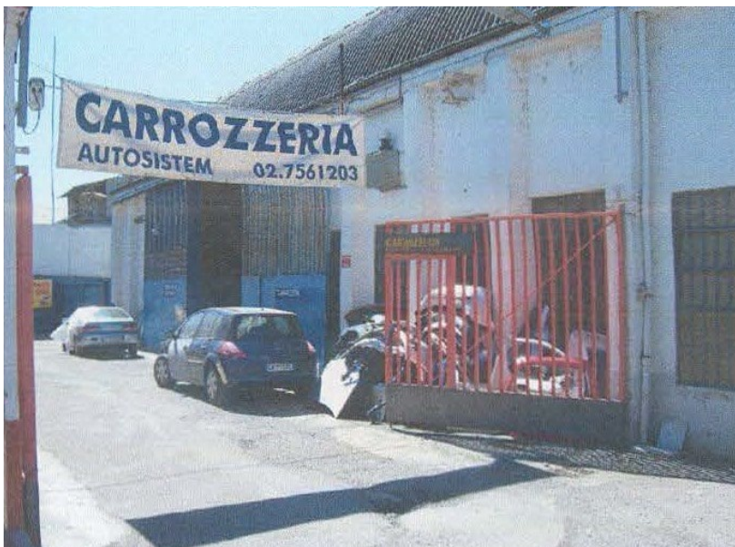
Foto ante lavori 2006/2015
