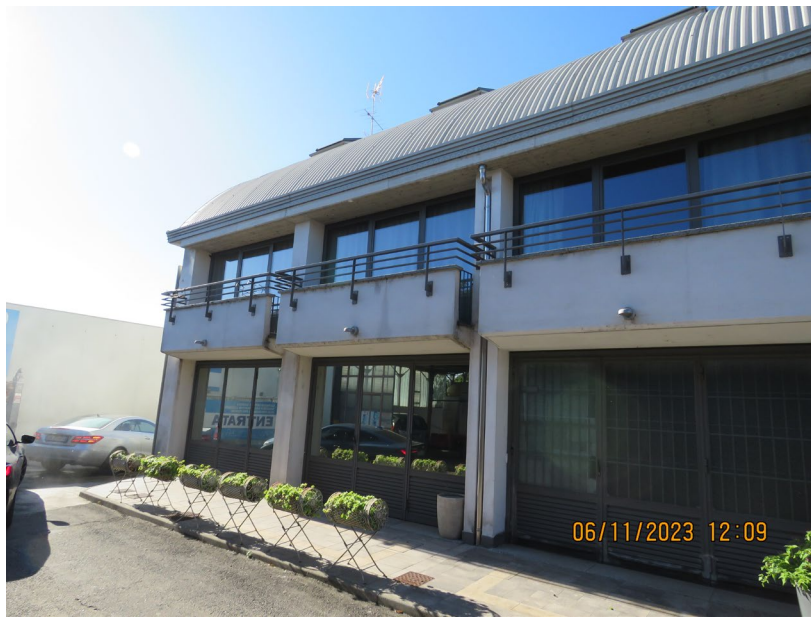
Foto post lavori 2006/2015
