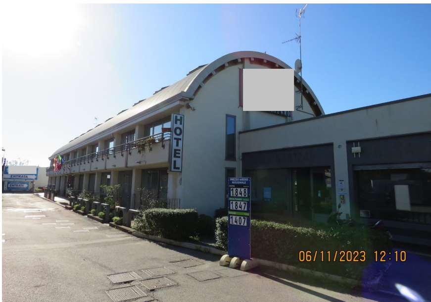
Foto post lavori 2006/2015
