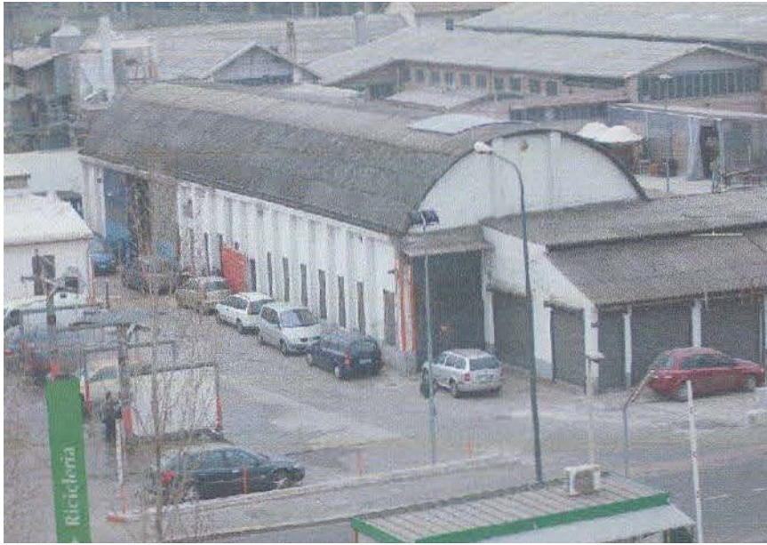
Foto ante lavori 2006/2015
