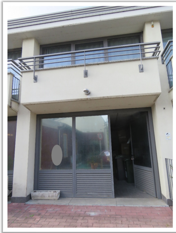
CORPO 3 – DEPOSITO piano terra.
