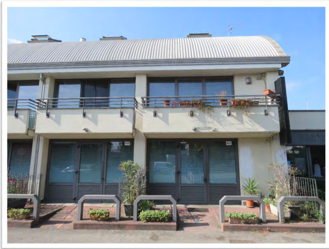
CORPO 2 – Abitazione ai piani terra e 1°: sopra: ingresso (prima porta a sinistra) e sotto: zona d'ingresso.
