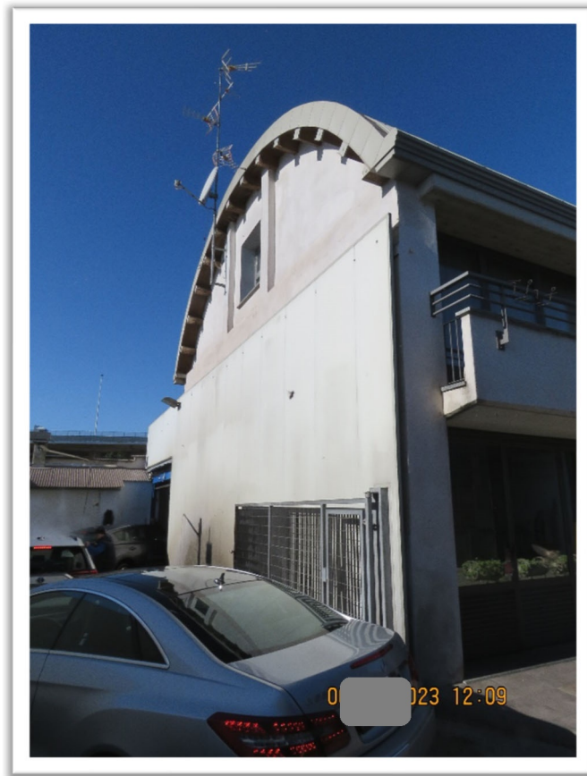
Sopra: vista Sud del fabbricato (CORPI 1, 2, 3 e 4). Sotto: particolare dell'ingresso all'Hotel
