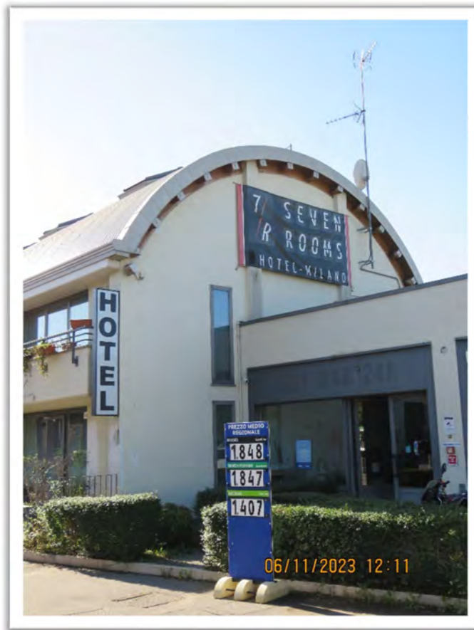
Viste Nord ed Est del fabbricato (CORPI 1, 2, 3 e 4).
