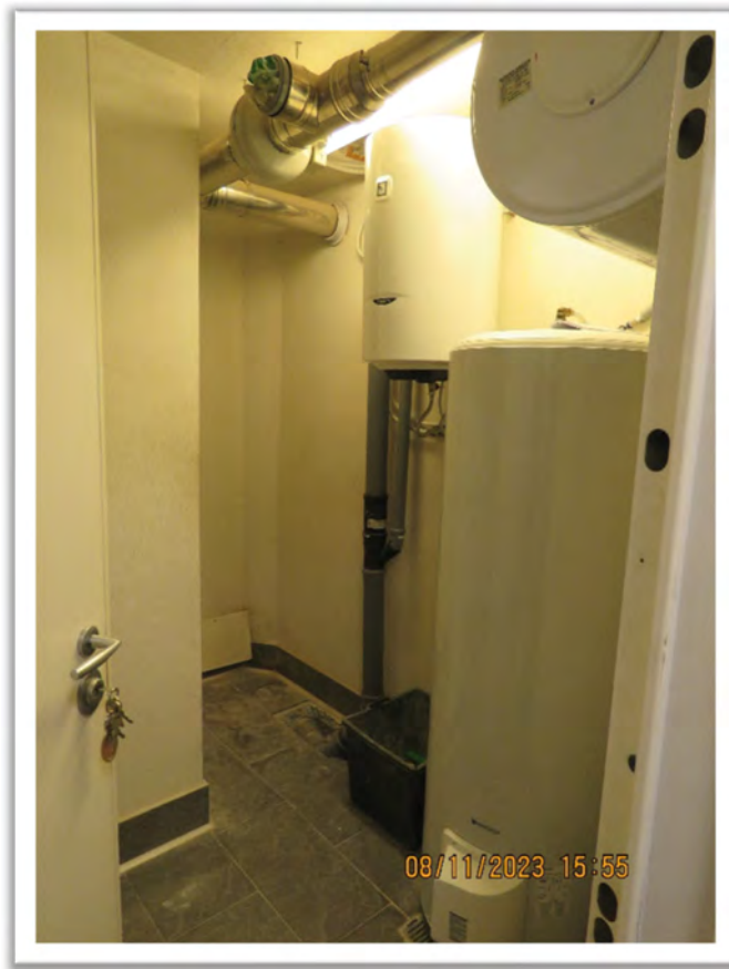
CORPO 2 – piano terra: vano impianti tecnici.
