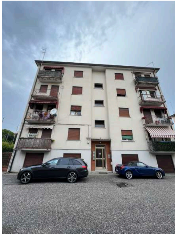
Vista esterna - Ovest
