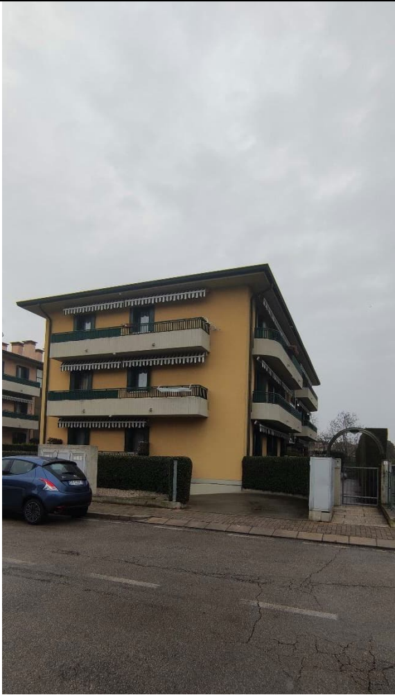
FOTO 1_AFFACCIO SU STRADA DEL CONDOMINIO TULIPANO CIV. 17
