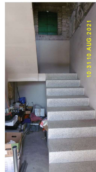
SCALA INTERNA COLLEGAMENTO PIANO PRIMO E SECONDO
