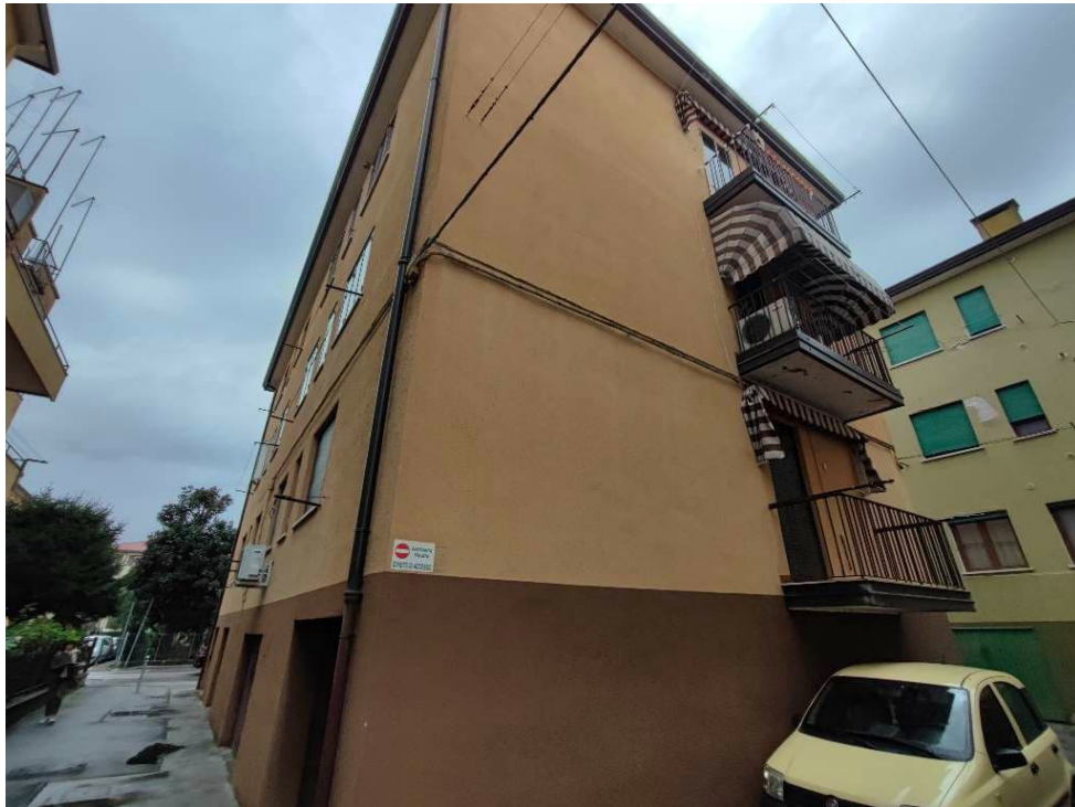
FOTO N. 4- prospetto est , stradina di accesso al garage
