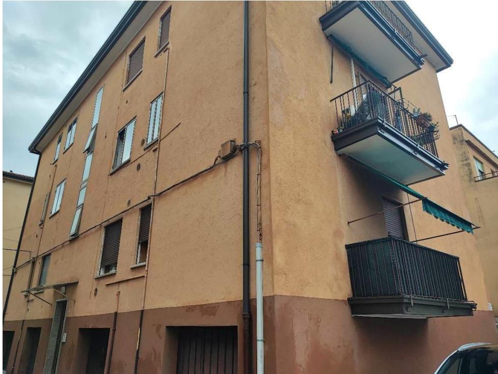
FOTO N. 3 – prospetto ovest del condominio
