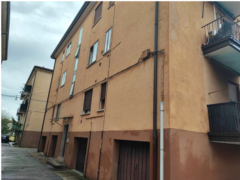
FOTO N. 2 - prospetto nord del condominio
