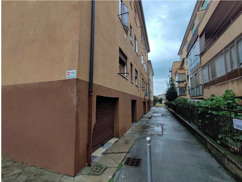
FOTO N. 5- prospetto sud, stradina di accesso al garage
