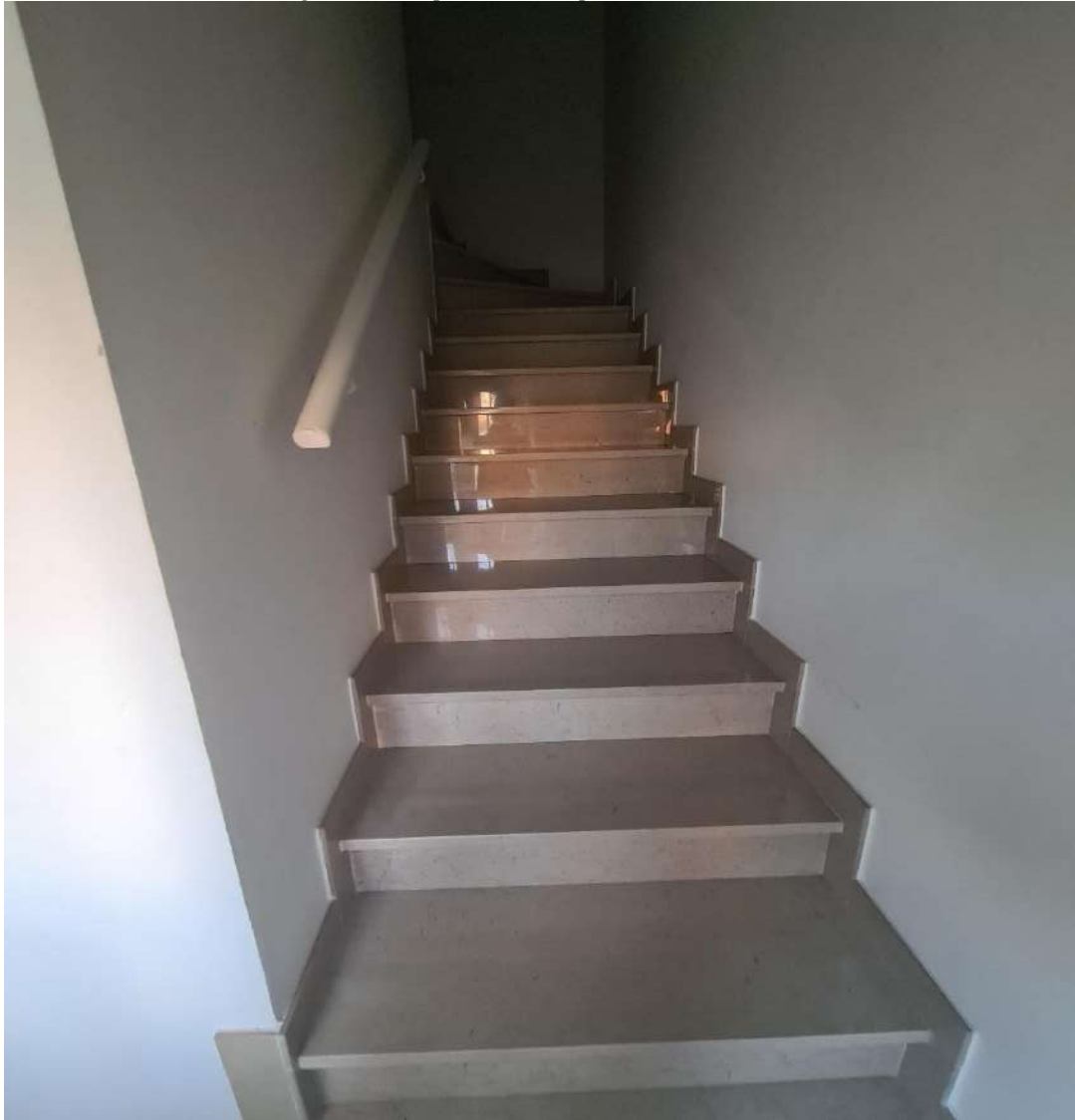
FOTO N° 17 – scala di collegamento tra piano terra e primo
