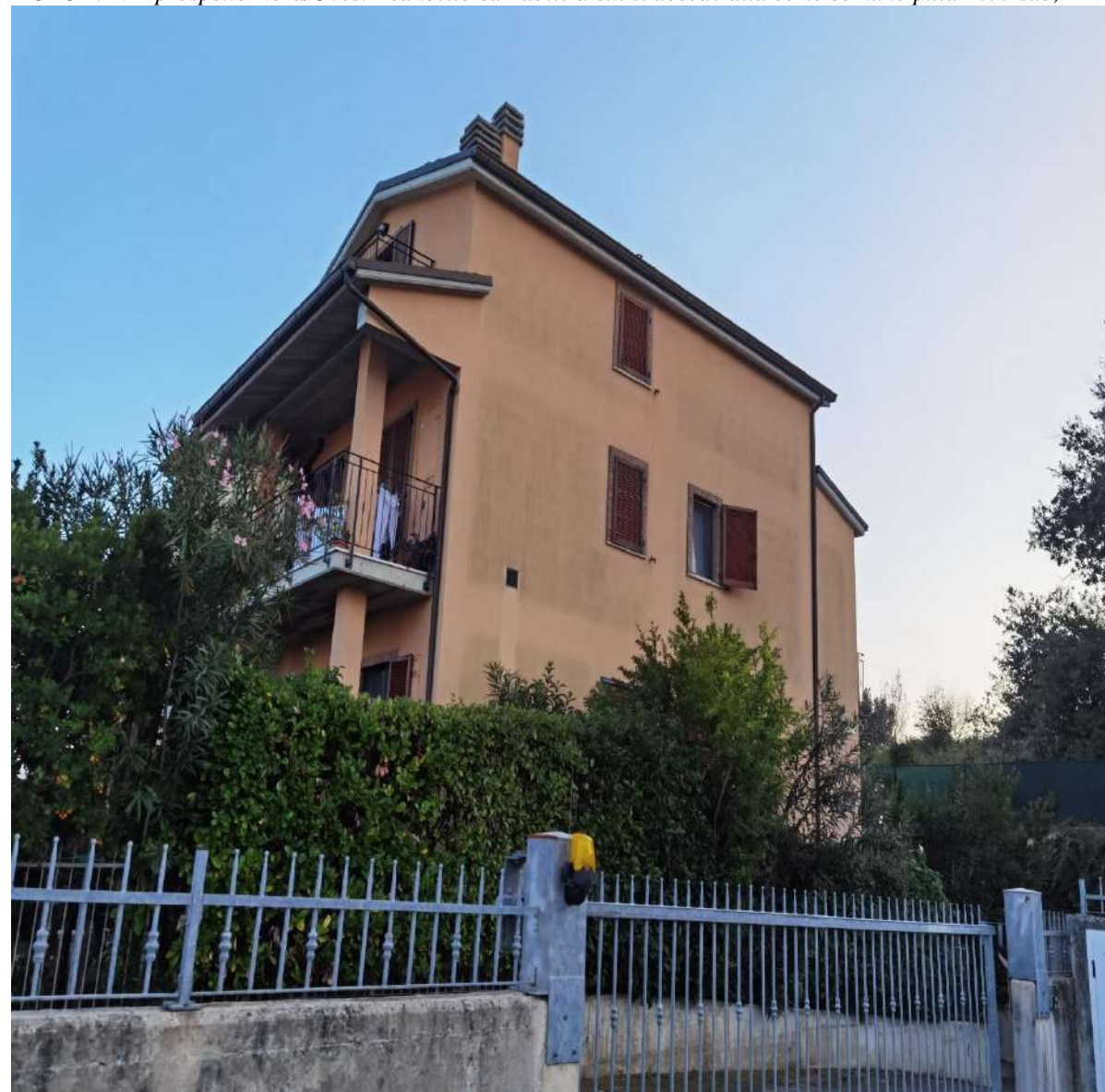
FOTO N° 6 – prospetto Nord/Ovest - cancello carrabile a cui si accede alla corte comune p.lla 1875 sub, 21
