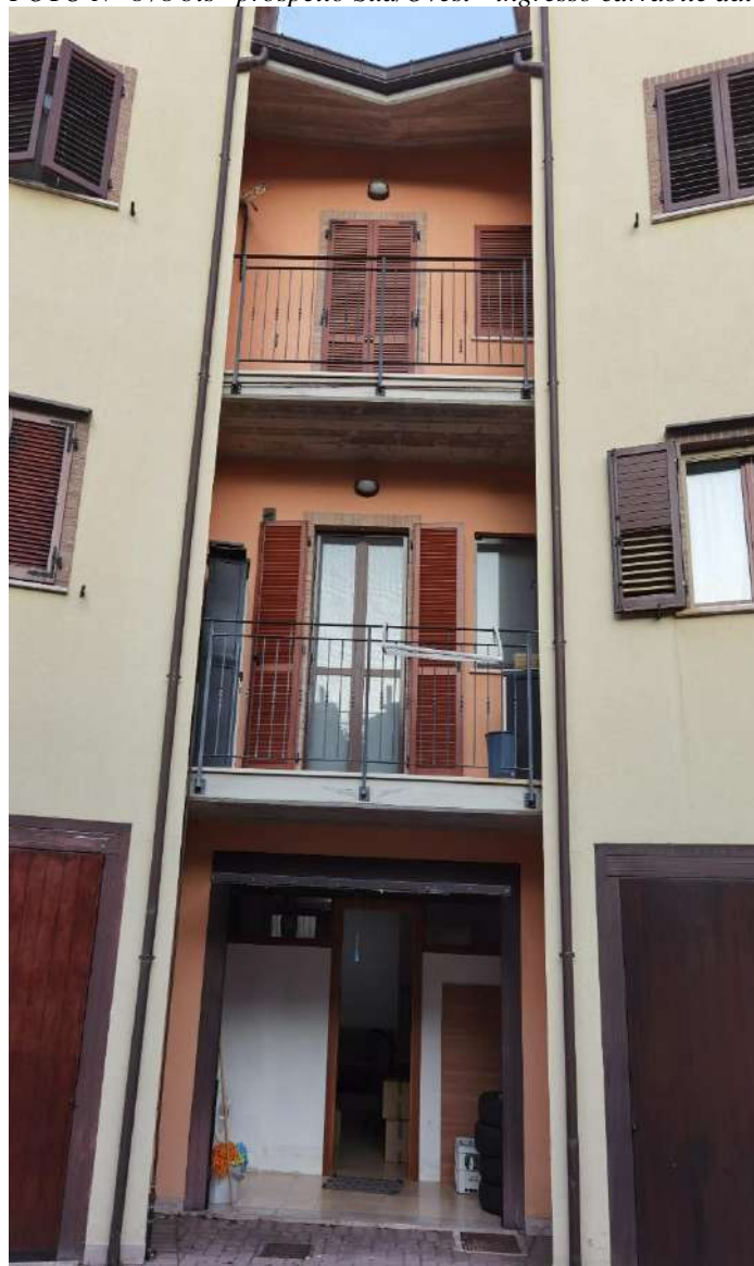
FOTO N° 8 /8 bis – prospetto Sud/Ovest - ingresso carrabile dalla corte comune sub. 21
