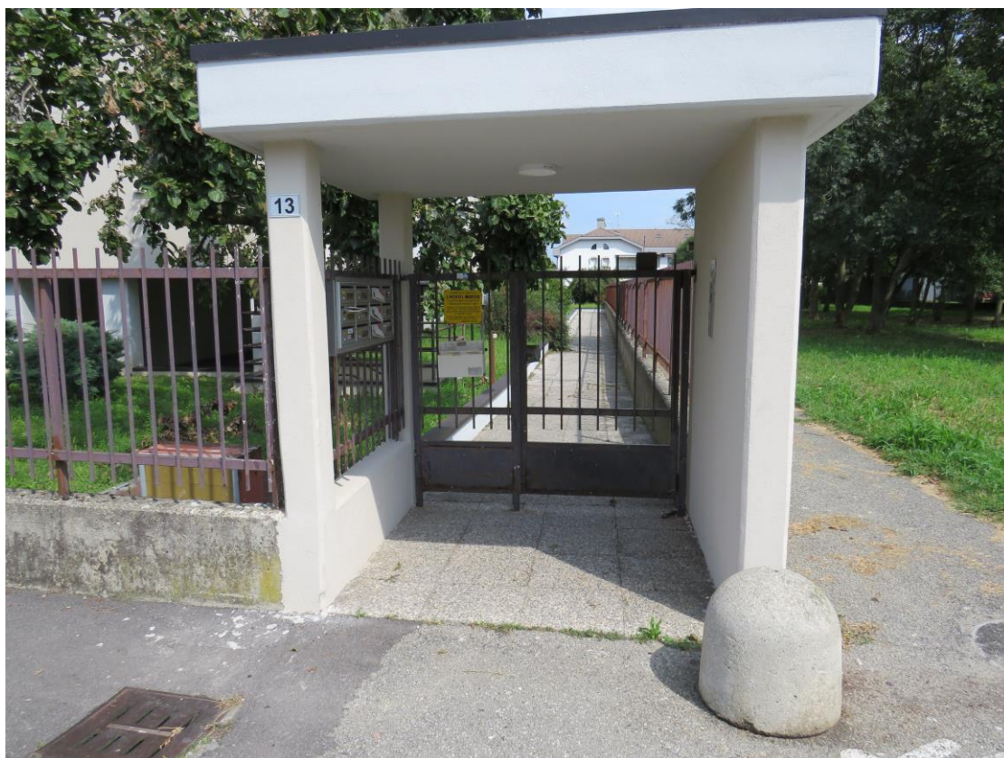
CANCELLO PEDONALE DI INGRESSO
