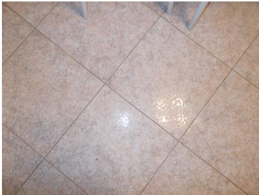
33. Dettaglio pavimento interno
