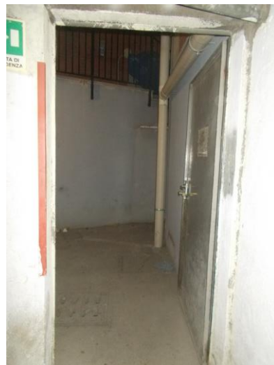
38. Ingresso alla zona cantine
