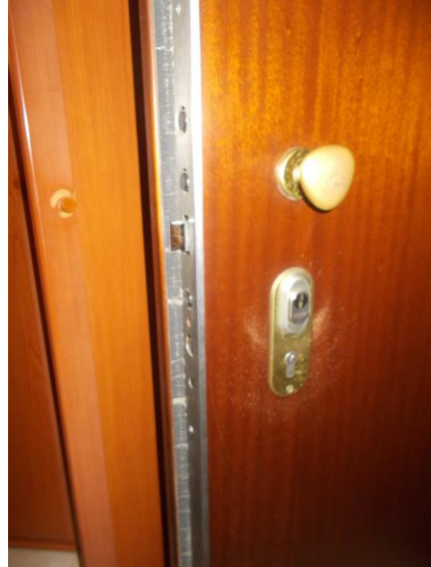
6. Dettaglio portoncino di ingresso
