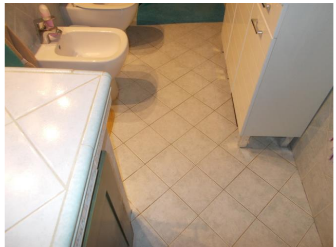
20. Dettaglio pavimento del bagno
